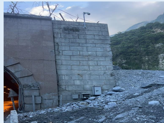
監控災點邊坡、路況
