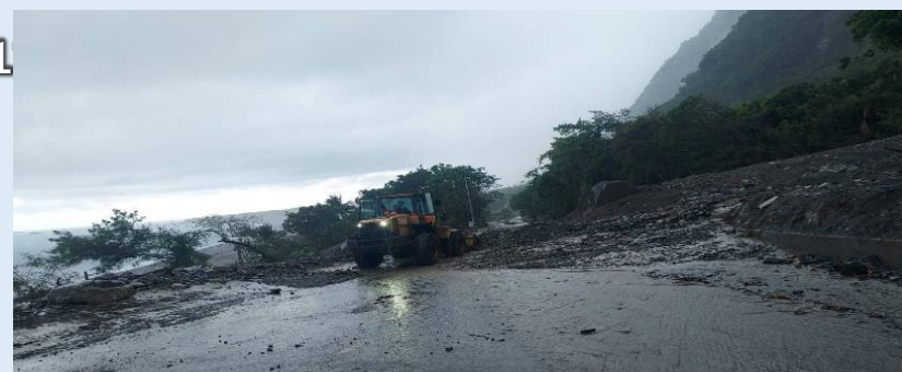
台9線164k+500路段土石流
