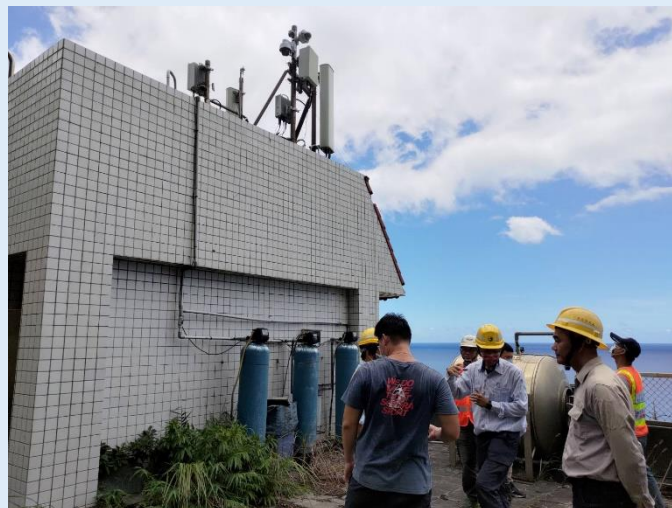
電力電信台鐵現勘
