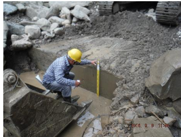
進行開挖檢測固床工基礎深度
