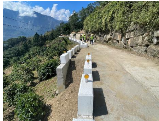
混凝土路面與塊狀護欄銜接不平順
