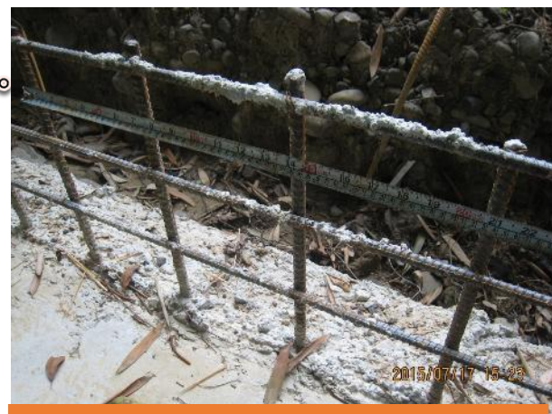
鋼筋跳步綁紮
