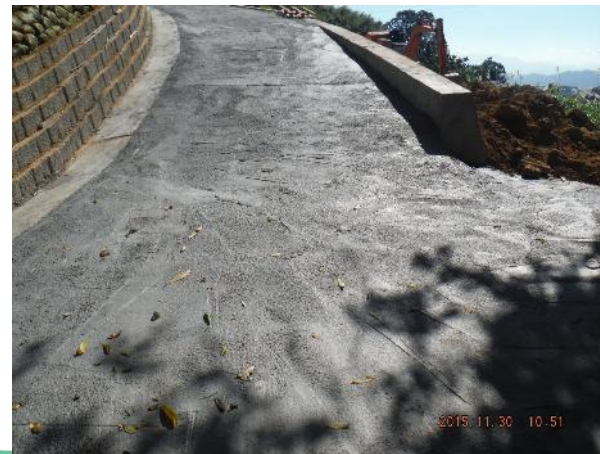
混凝土路面與塊狀護欄銜接不平順
