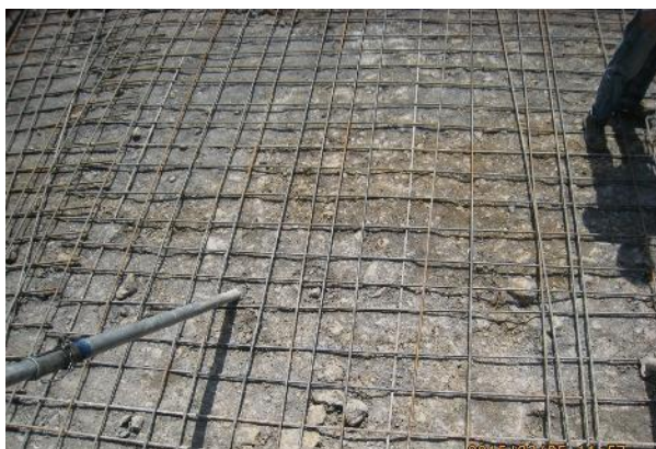
鋼筋未確實綁紮以致間距不符設計大小
