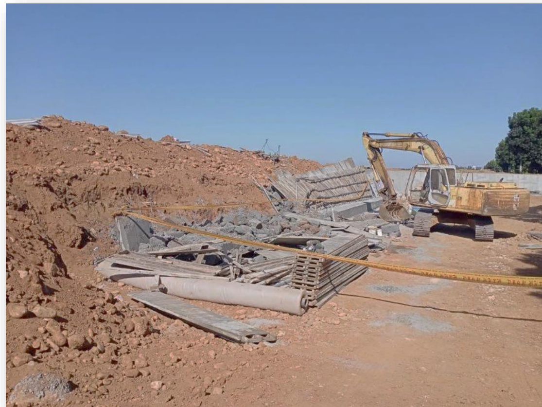
未依規定時間拆模及回填
