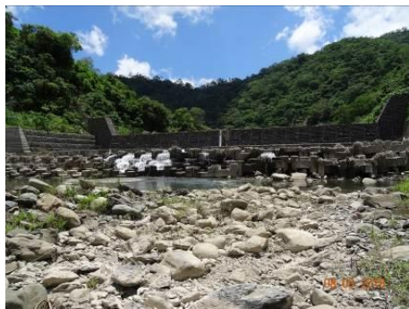
屏東里仁溪防砂壩
