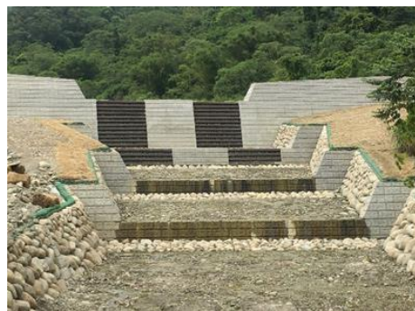
台中茄荖寮溪防砂壩
