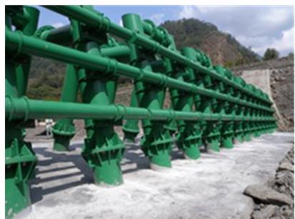
南投蘭島溪下游鋼管壩
