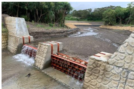
屏東東門溪出火野溪防砂壩
