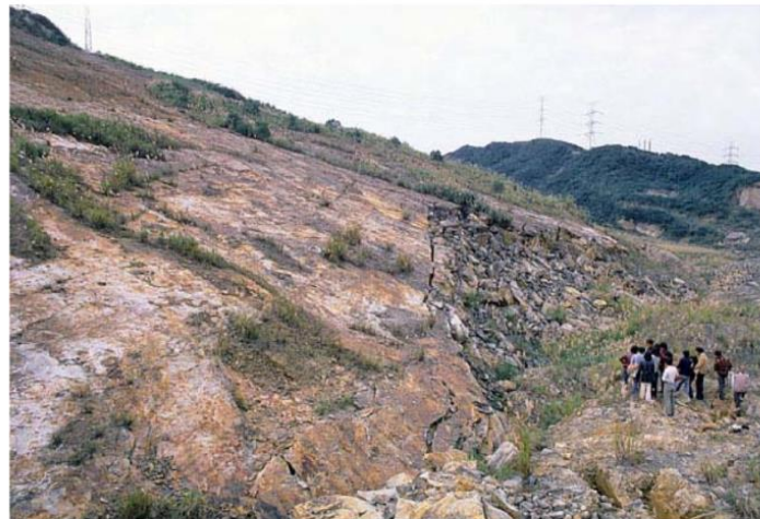
照片 2.315 基隆市大竿林中新世砂岩低傾角順向坡，人工自由面地滑，滑動體仍呈整體狀。(基隆市中山區德安里)
