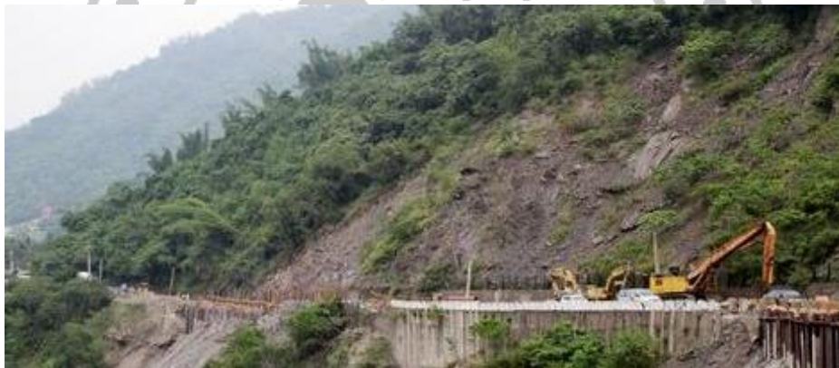
圖 5-1 高 133 線道因土石流崩坍整修施工照
