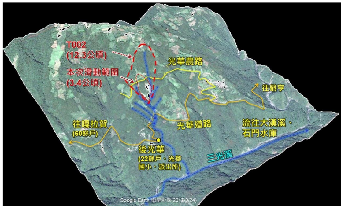
圖 3-3 光華崩塌潛勢區地勢與保全對象圖 (農村發展及農村水保署資料管理平台，2024)
