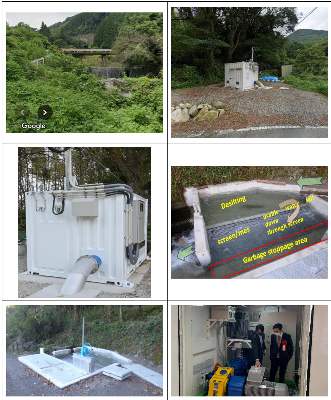
圖 2-2-2 日本佐賀縣松熊村小水力發電站照片
