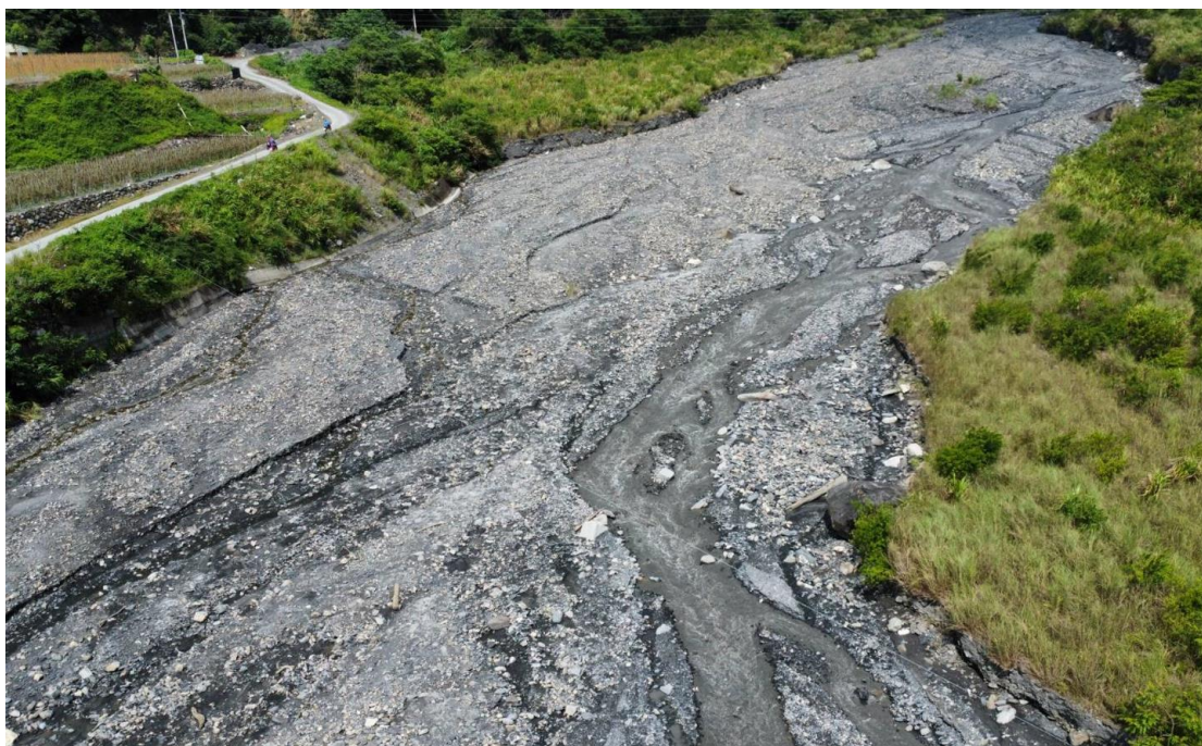
圖 3-3-11 十八重溪集水區十八重溪橋空拍照片
