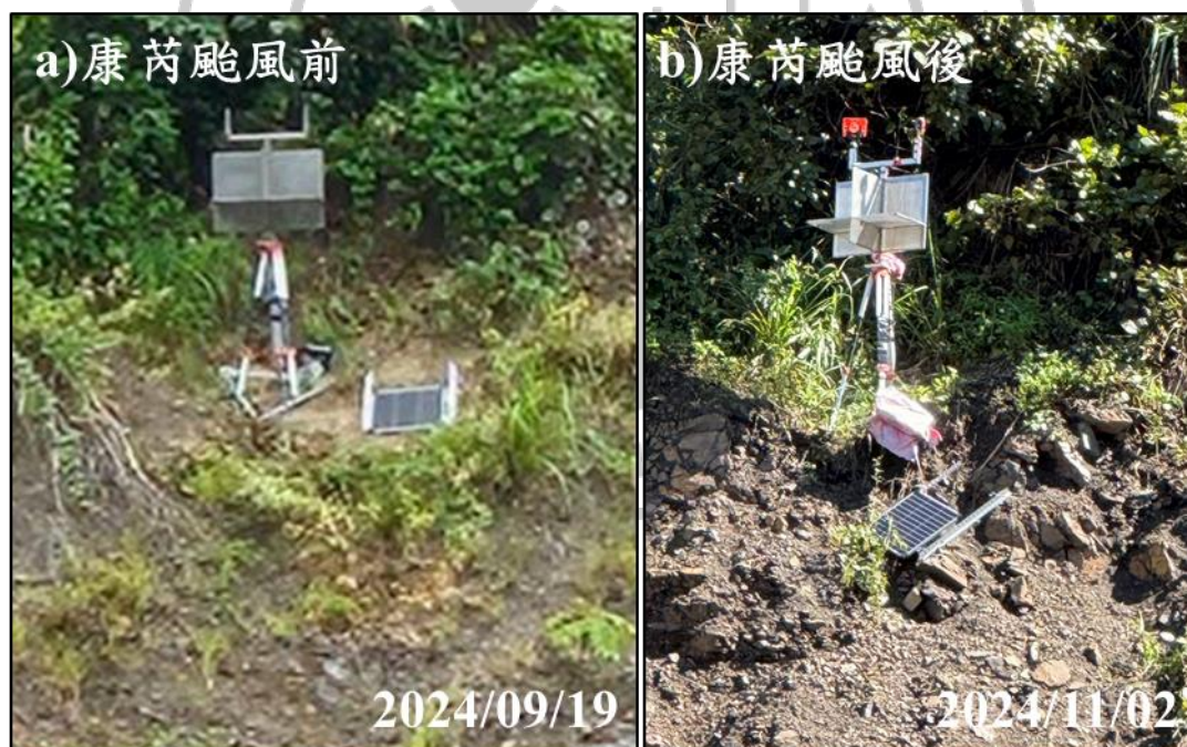
圖 3-50 康芮颱風前後角反射器下方土石侵蝕掏空
