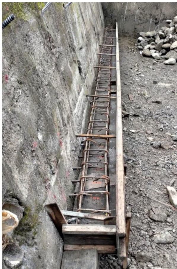
圖 32a 螺紋錨栓應用於力里溪攔砂壩生態延壽整治工程混凝土灌漿前照片
