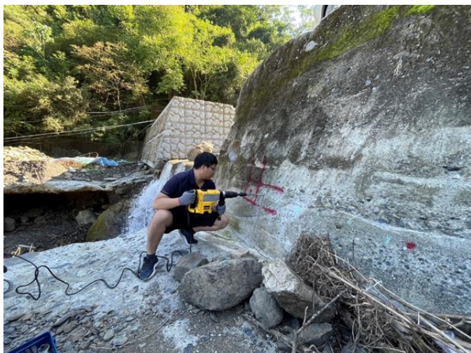
圖 30a 以扭距板手將螺紋錨栓植入攔砂壩體中
