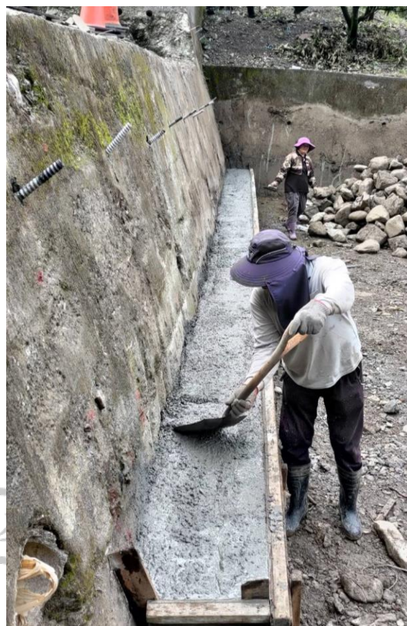
圖 32b 螺紋錨栓應用於力里溪攔砂壩生態延壽整治工程混凝土灌漿後照片
