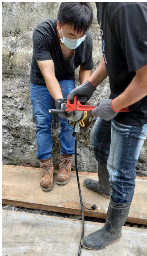
圖 3-28a 錨栓現場試作照片 A
