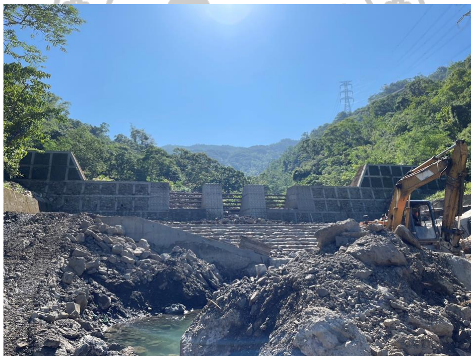
圖 3-29 屏東縣春日鄉力里溪攔砂壩生態整治為梳子壩工程現況
