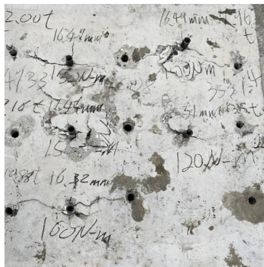
圖 3-25 Type C 錨栓植入 C 35/43 開裂混凝土(4/A4) 非束制 抗張試驗照片
