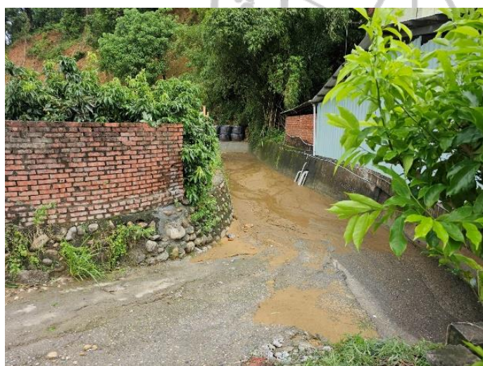
圖 3-33a 高雄市大樹區野溪整治右岸年久失修及溪底沖刷待維護現址照片 A
