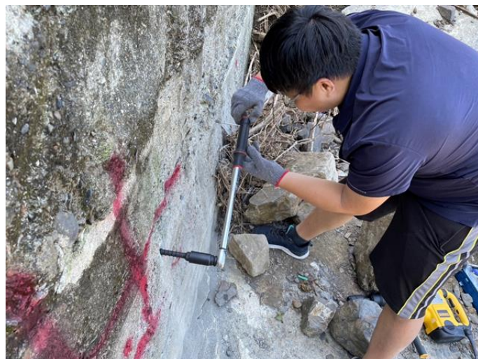
圖 30b 植入壩體螺紋錨栓可供與延壽補強鋼筋連結用
