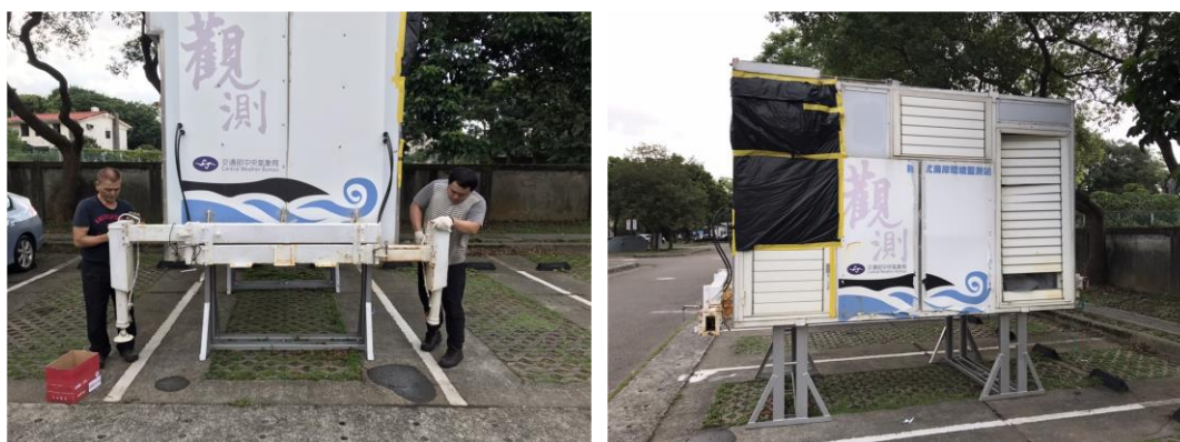
圖 3- 57 車廂整理(2)-液壓系統整理翻修
