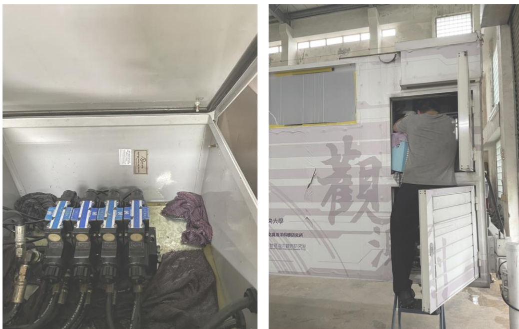
圖 3- 54 液壓系統電子控制閥漏油維修(1)
