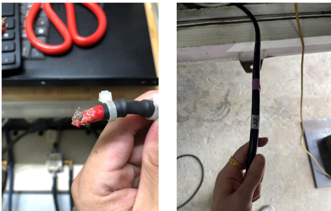
圖 3- 60 電源線整理與補強(1)
