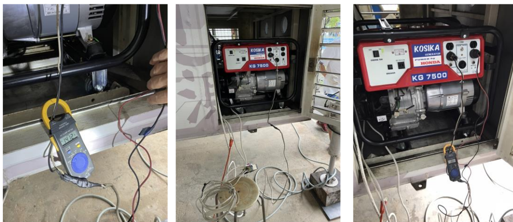
圖 3- 46 GB-SAR 車廂發電機(3)-輸出電流調校
