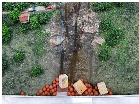
圖 5 土石與房屋於坡趾處堆積
