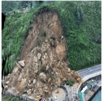
2024/6/3 基隆市長潭里 省道台2線70K+004 (基隆市潮境公園) 邊坡崩塌事件
