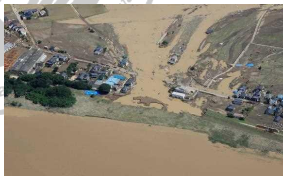
堤防潰決引致家屋流失（鬼怒川）
