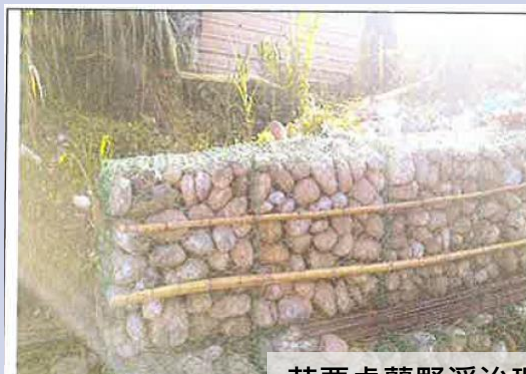
苗栗卓蘭野溪治理工程
