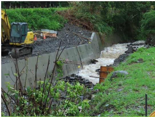
萬豐村投014(投縣DF025)土石流特定水土保持區河道既有構造物維護暨梳子壩工程
