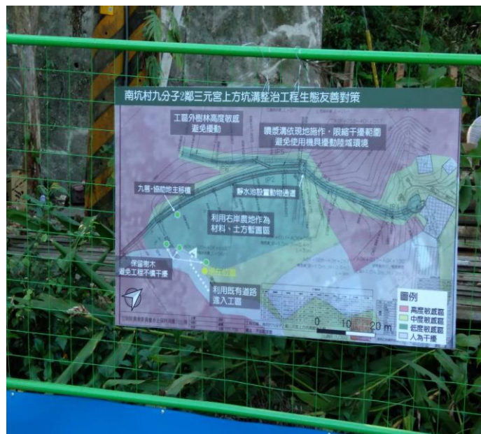
南坑村九分子2鄰三元宮上方坑溝整治工程
