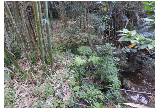
農投鹿017社區農路排水改善工程
