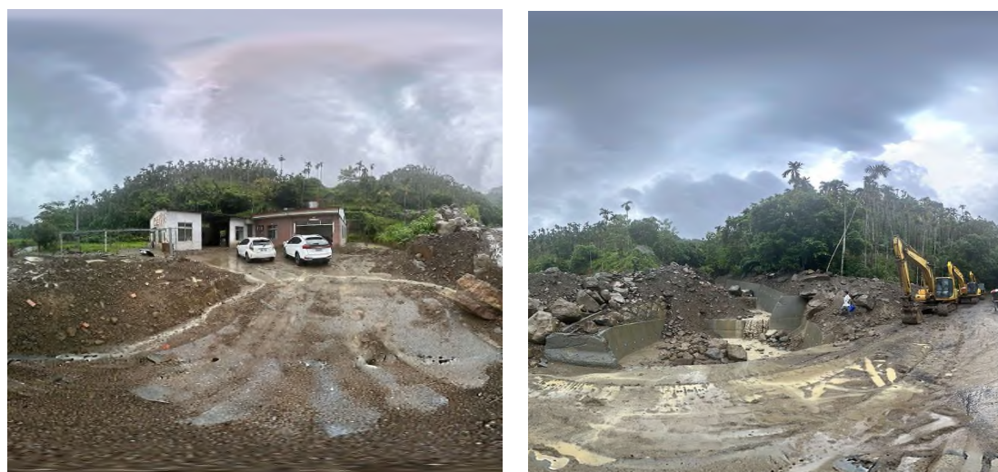
圖 4-39 土石流潛勢溪流-嘉縣-DF051 土石流災害事件-現場狀況 (113/8/16 現場拍攝)
