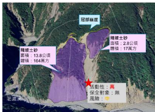
殘坡土砂判釋與數化
