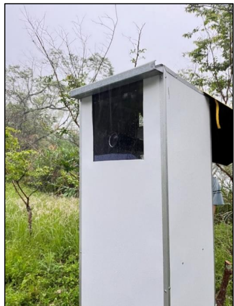
監測小屋外部
