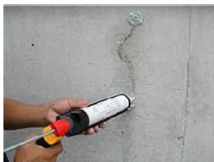
照片4.2.2-2 設置注入用之墊圈 與裂縫表面密封狀況
