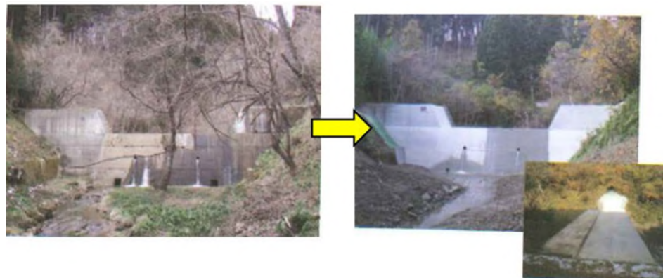
圖 8-3 2008年岩手與宮城內陸地震時以節制壩加厚實施之災害復舊案例
