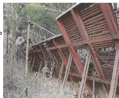
圖7-7支墩壩式節制壩之修補案例(主鋼材:除鏽作業後再塗裝，壁材:更換成新材)
