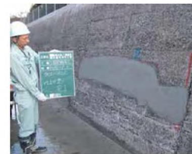
照片4.2.1-2 斷面修復完成
