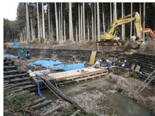
5. 組裝、充填(充填石材可再利用)
