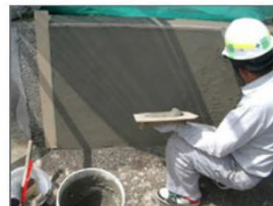
照片2.2.1.1-1 無機類被覆工法（水泥匠工法）施工狀況
