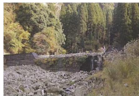
圖7-8鋼製框固工之加厚、加高案例(壩高5m→8m)
