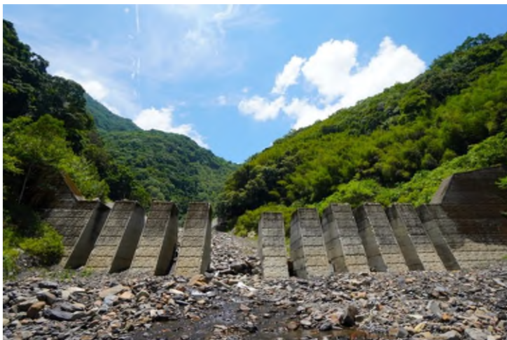
梳子壩(混凝土)
