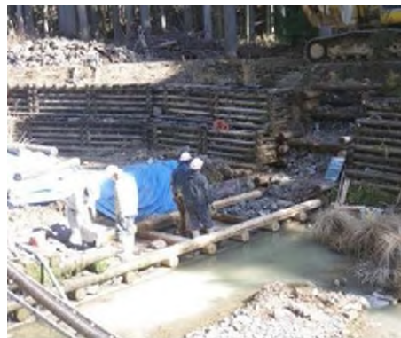
4. 組裝、充填(充填石材可再利用)
