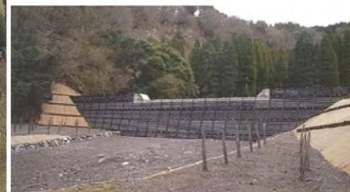
圖7-8鋼製框固工之加厚、加高案例(壩高5m→8m)
