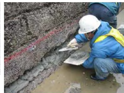
照片4.2.1-1 斷面修復材充填
