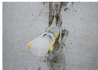
照片4.2.2-3 以注入器具進行注入
