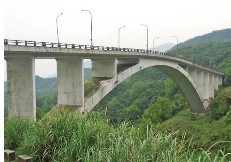
圖 12 台灣第一座熱浸鍍鋅橋梁—馬槽橋
