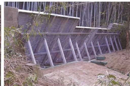
圖7-7支墩壩式節制壩之修補案例(主鋼材:除鏽作業後再塗裝，壁材:更換成新材)
