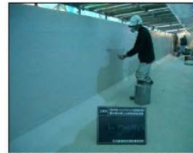
照片2.2.1.2-1 有機類被覆工法（塗刷型）施工狀況
