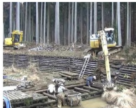
2. 木材構件、充填石材之拆除
