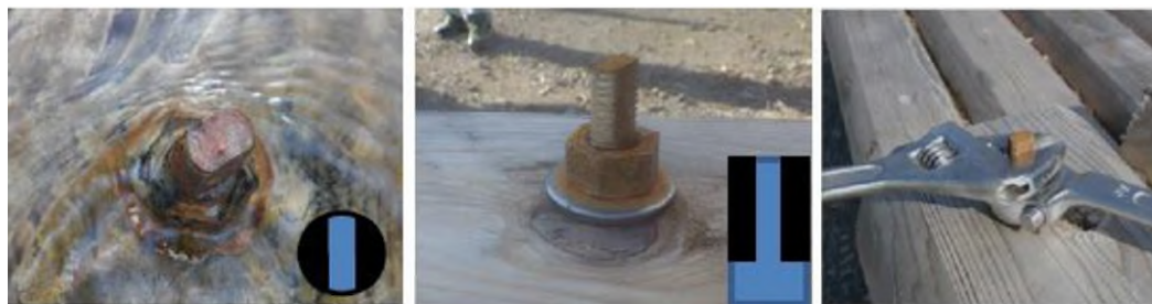
圖 9-3更換木製構件時容易從一邊鬆開生鏽螺栓、螺栓頭部做成突起之做法
