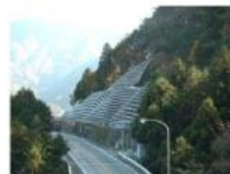
坡面崩塌防止對策
