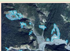
事件型崩塌土砂LSS (>2 ha 崩塌面積)
