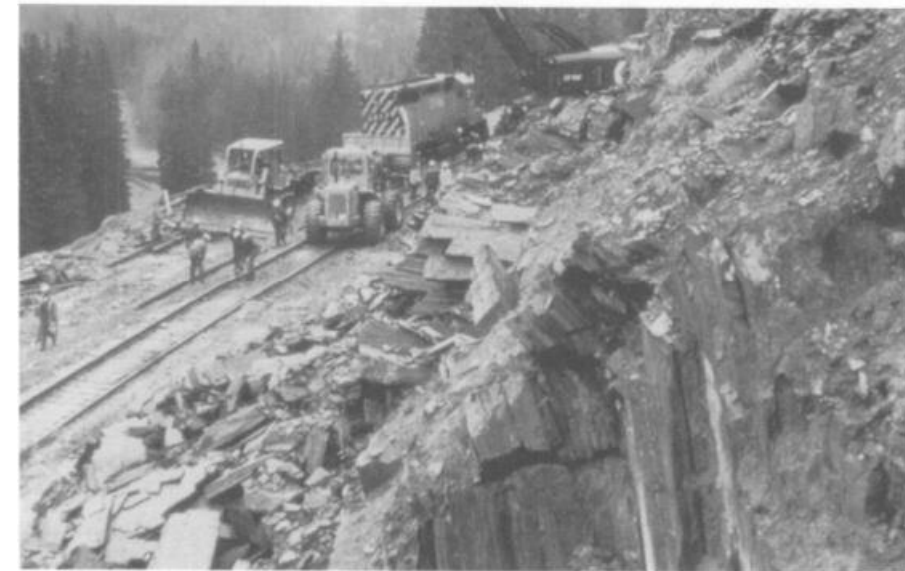
圖 5.16：應注意傾覆破壞，這也是一種逆向接合。
