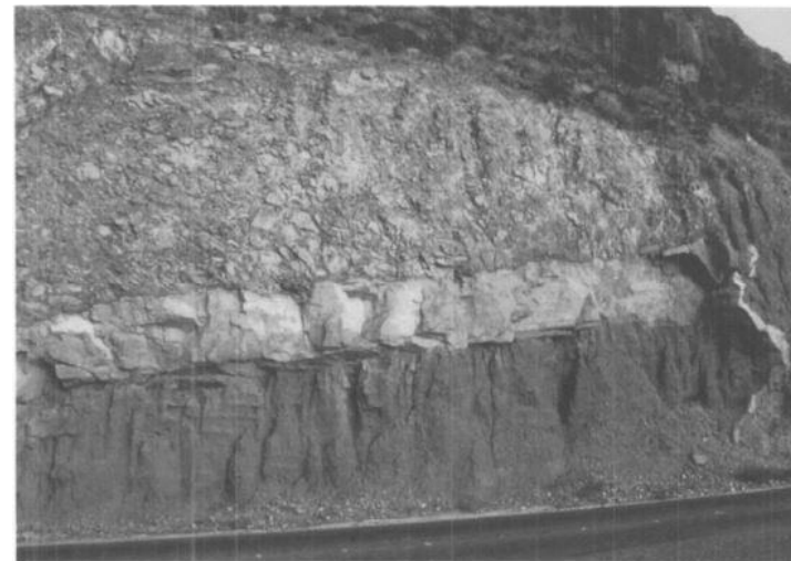
圖 5.24：層狀材質容易出現差異性沖蝕
