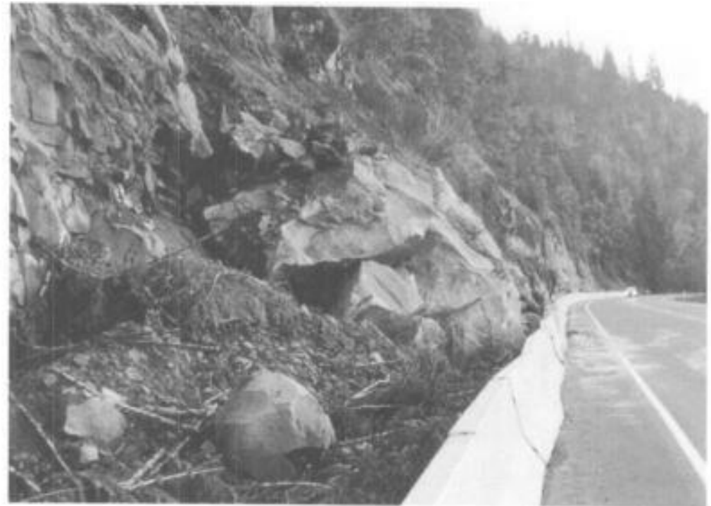
圖 8.2：當大塊落石落下時，碎片會掉落到道路上，未來的落石尺寸將會更小並落在排水溝中。
