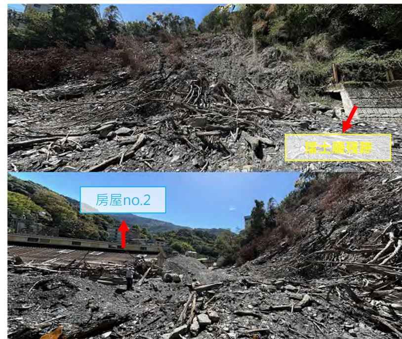
大規模崩塌潛勢區(投縣-仁愛-D067)右下方坡腳崩塌 崩塌本體左側尚存房屋no.1，前方尚有房屋no.2，房屋no.2左已被人工堆積土方環繞，崩塌本體右側尚存既有擋土牆
