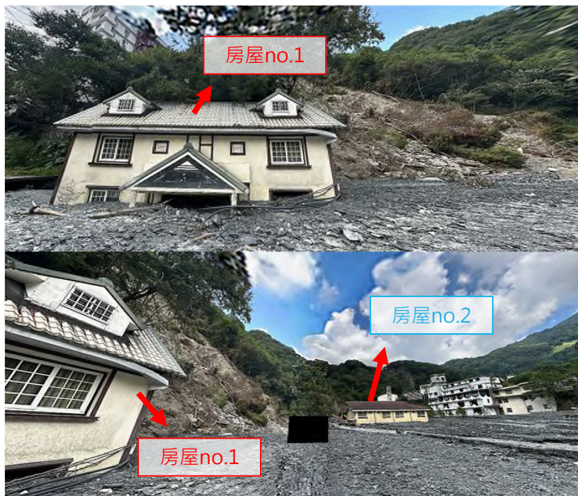
大規模崩塌潛勢區(投縣-仁愛-D067)右下方坡腳崩塌 崩塌本體左側尚存房屋no.1，前方尚存房屋no.2
