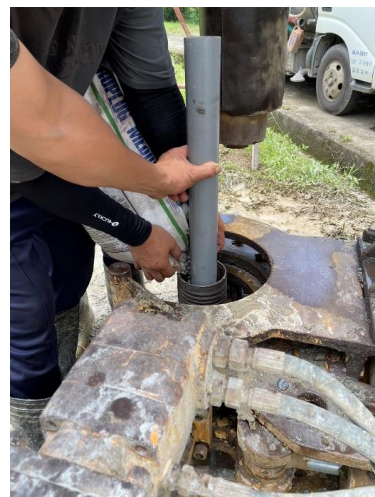
濾料回填過程
