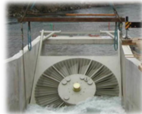
適用於超低落差水輪機(VLH)
