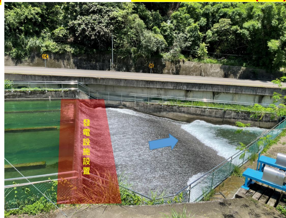
適用於超低落差水輪機(VLH)
