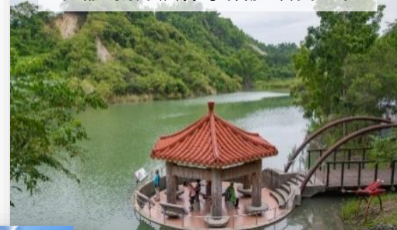
牛埔2號滯洪保水設施改善工程
