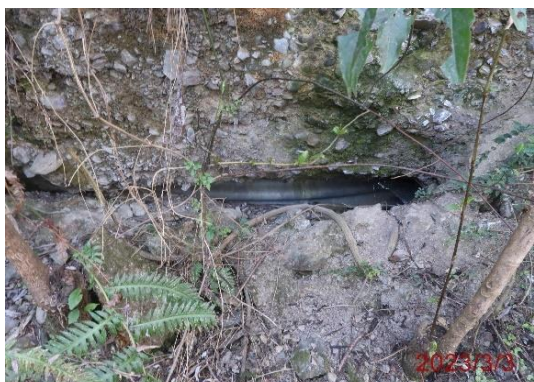
集水井井桶鋼襯版裸露
