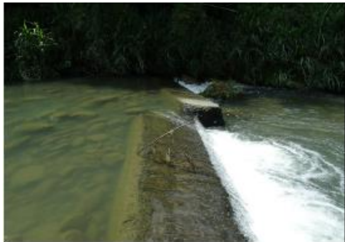
左側斷裂錯動位移
