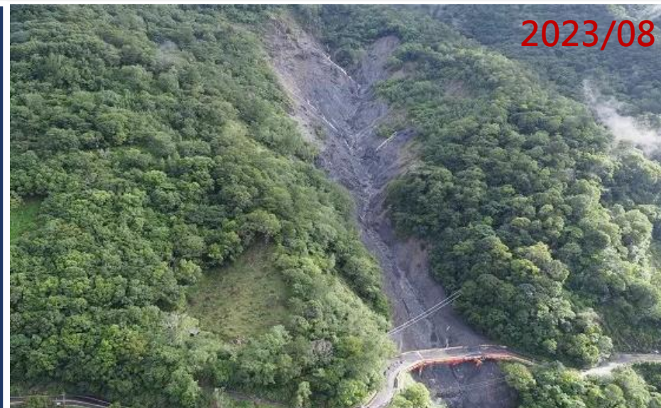
萬大溪集水區崩塌災害
