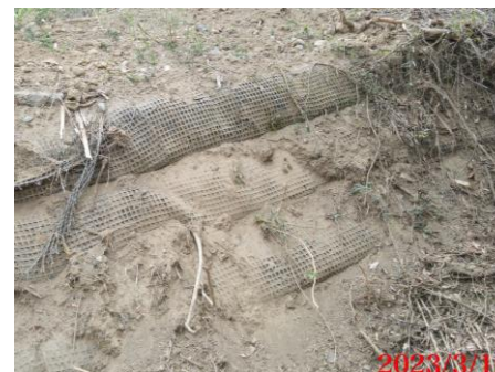
加勁材破裂
