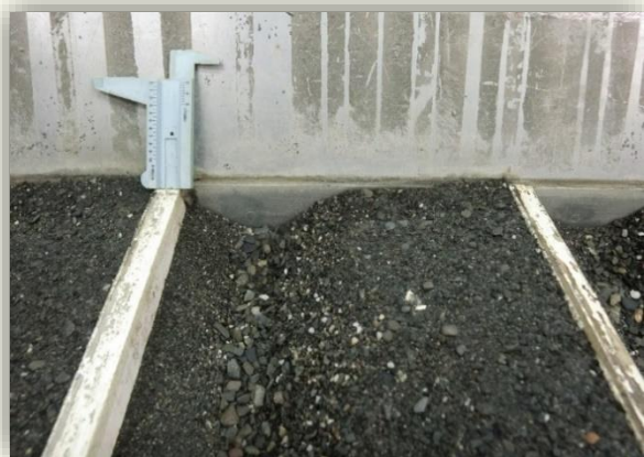
傳統式固床工 趾部淘刷側視
