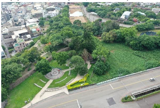
(c)橋頭寮溪(中市 DF080，鰲峰山運動公園)
