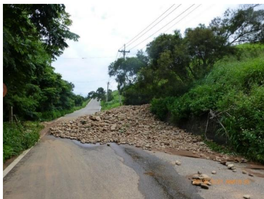
圖 5-20 潭美颱風(2013)時米粉寮溪支溝發生土石流 (台中市水利局網頁)
