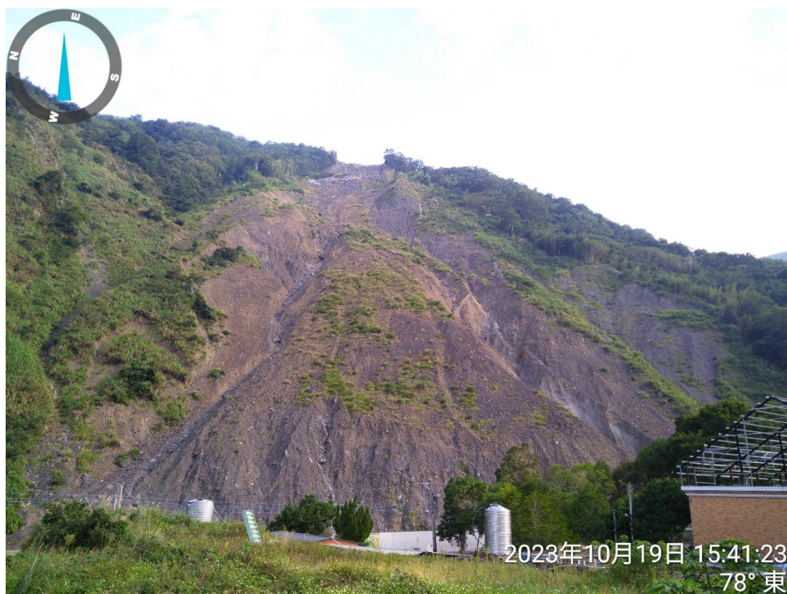
圖 3-12 DS194 崩塌地現地照片(2023/10/19)
