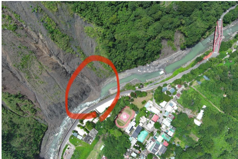
圖 1-8 秀巒崩塌地土石堆積於河道情形(2023/7/1)
