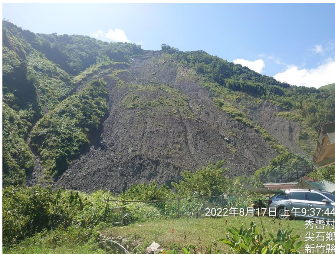
圖 3-10 DS194 崩塌地現地照片(2022/8/17)
