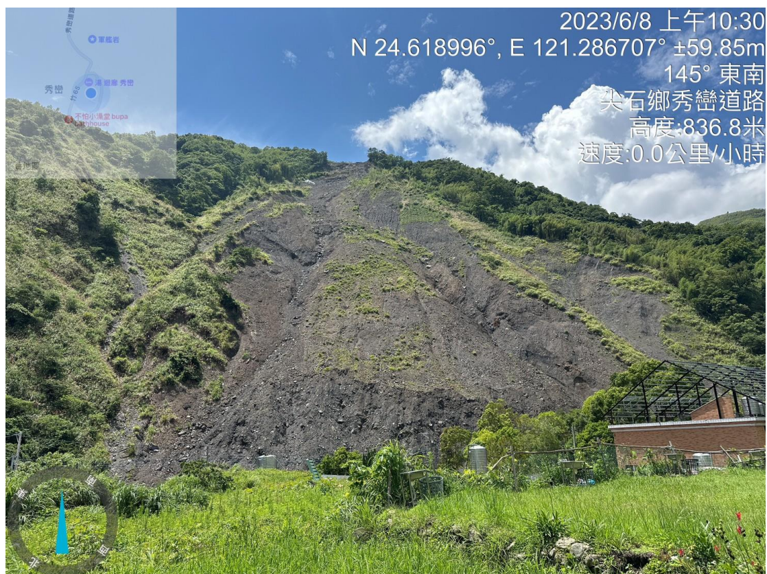
圖 3-11 DS194 崩塌地現地照片(2023/6/8)
