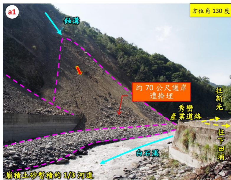
圖 1-5 民國 105 年十月 DS194 崩塌地現場照(農村水保署，2016)
