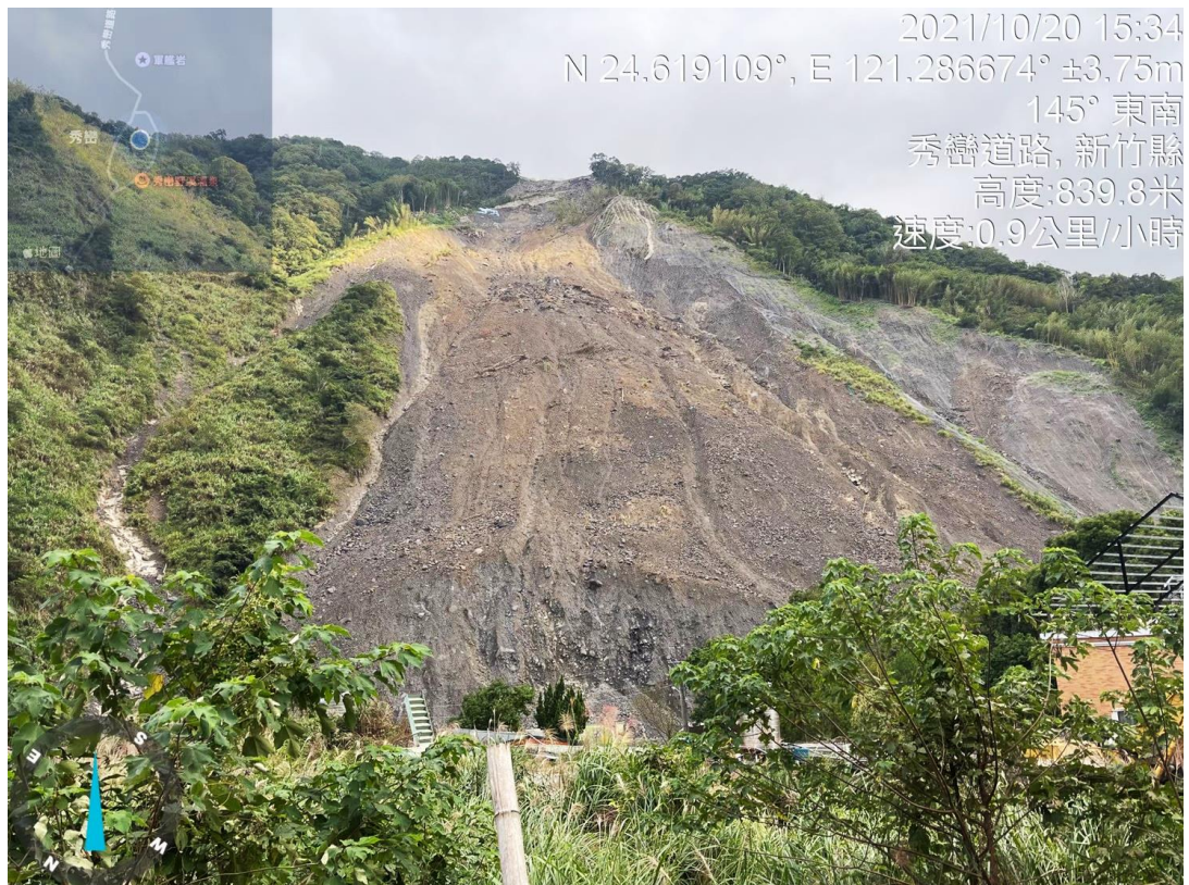
圖 3-7 DS194 崩塌地現地照片(2021/10/20)
