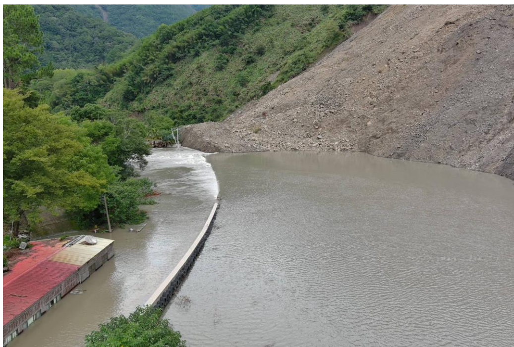
圖 1-7 民國 110 年九月白石大崩塌現場照
