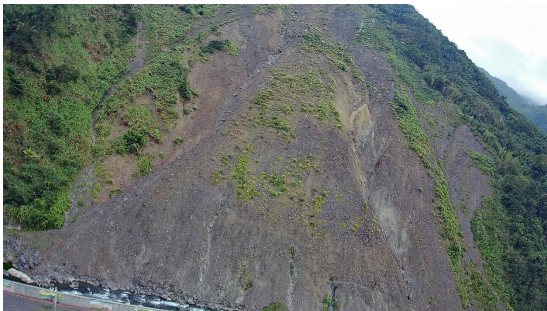
圖 3-13 DS194 崩塌地現地照片(2023/10/26)-空拍照
