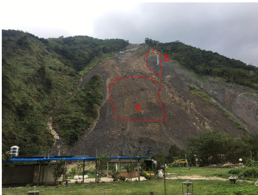
圖 4-22 秀巒白石崩塌現地位置圖
