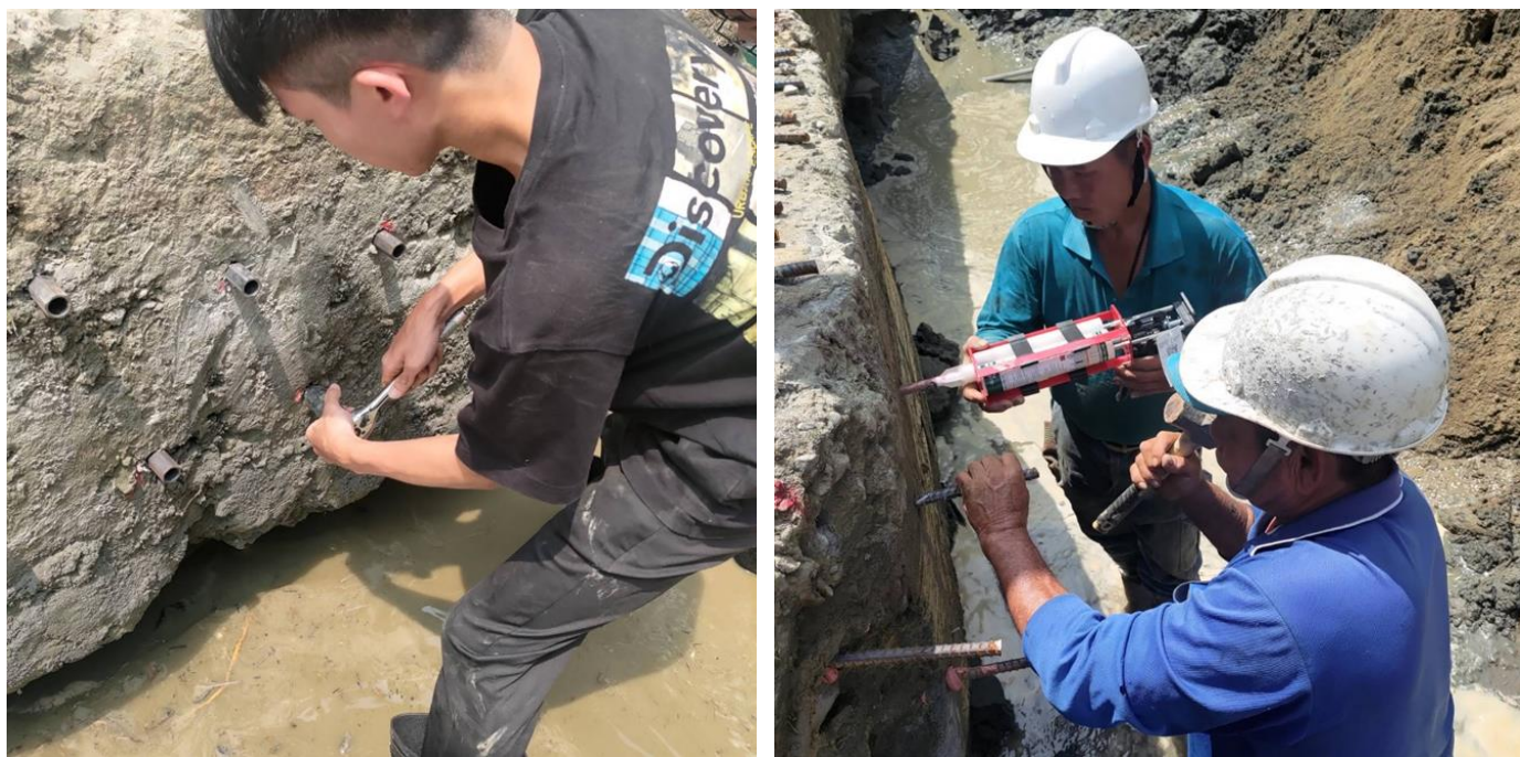
圖 4-3 螺紋錨栓與化學錨栓植筋作業
