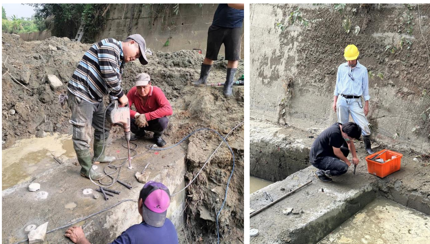
圖 4-8 新式螺紋錨栓植筋與化學植筋現地試驗鑽孔與植筋作業
