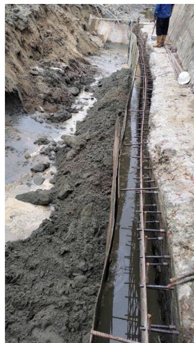
圖 4-5 混凝土護岸基礎補強混凝土模板組立與混凝土澆置
