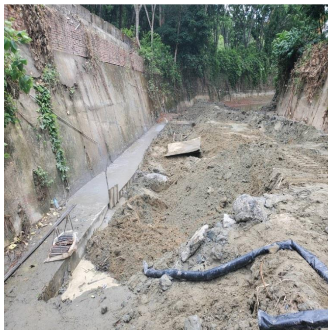
圖 4-6 混凝土護岸基礎補強施工前與施工完成後照片
