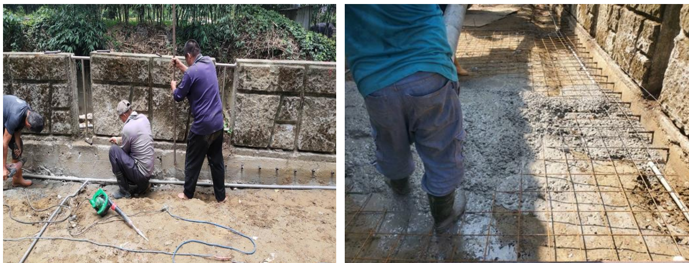
圖 4-7 新化林場入口混凝土路面補強新式螺紋錨栓植筋安裝與鋼筋網鋪設作業
