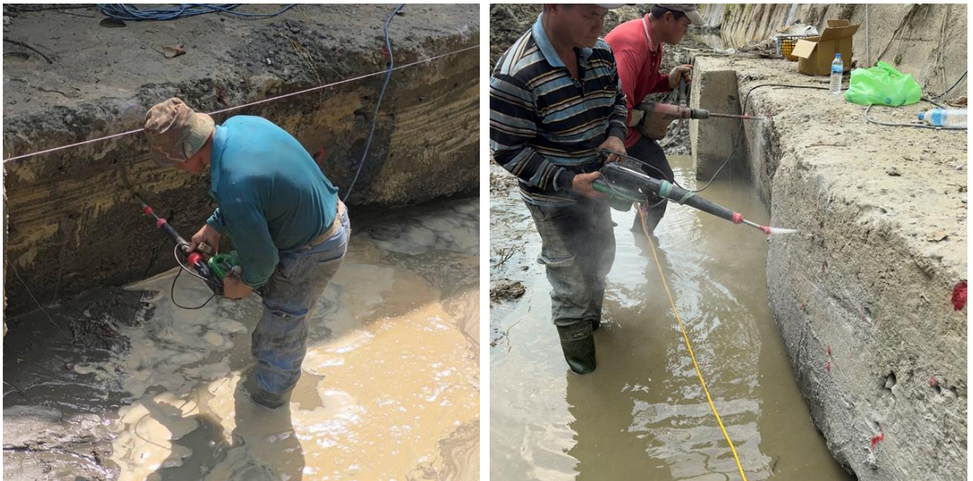
圖 4-2 植筋鑽孔與清孔作業
