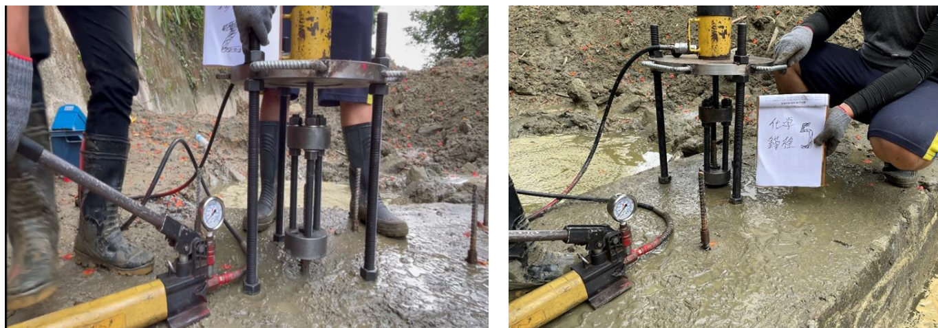
圖 4-9 新式螺紋錨栓植筋與化學植筋現地抗拉試驗作業
