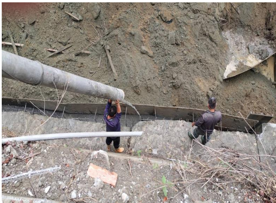
圖 4-5 混凝土護岸基礎補強混凝土模板組立與混凝土澆置
