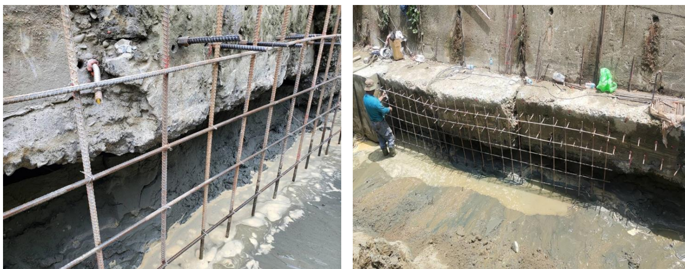
圖 4-4 混凝土護岸基礎掏空狀況及植筋與鋼筋綁紮補強作業後灌製混凝土前概況
