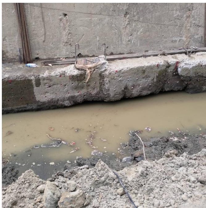
圖 4-6 混凝土護岸基礎補強施工前與施工完成後照片
