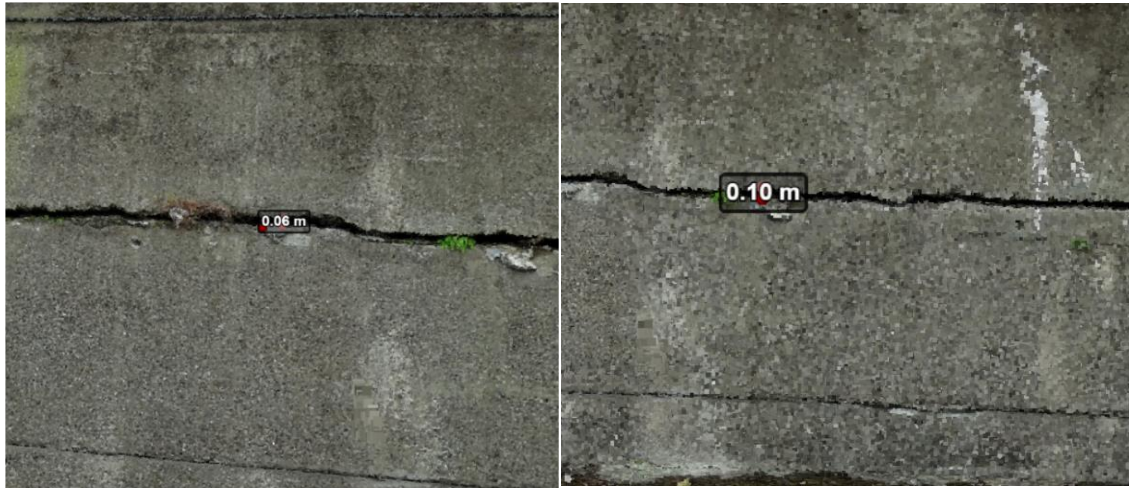
圖 2-4:影像重新建模寬度(左圖)0.06m(60mm); (右圖)0.10m(100mm)之裂縫
