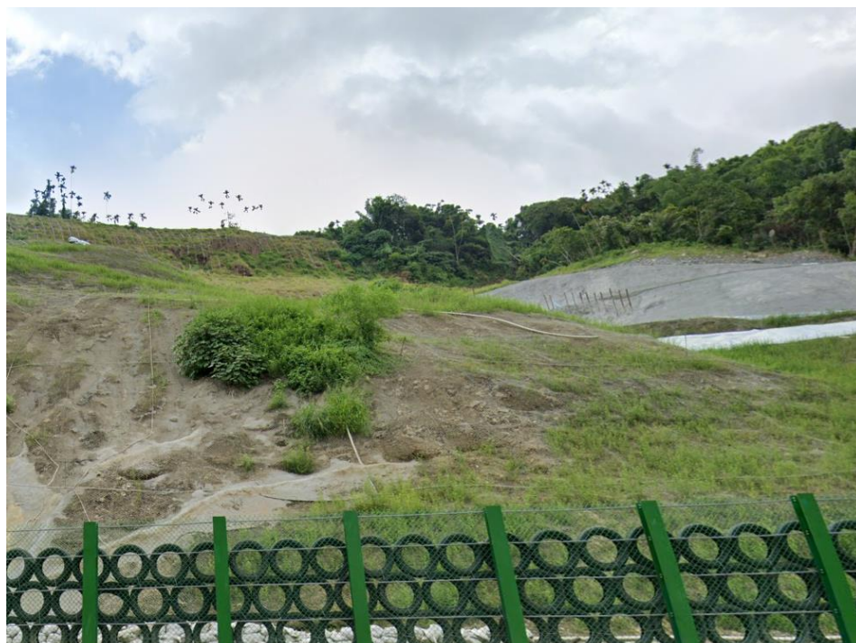
圖(2-18) 集集隧道崩塌地邊坡整治
