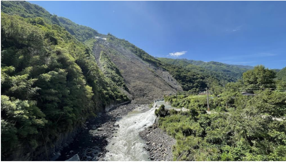
圖 4-1 計畫區域崩塌地照片(團隊於 2021.09.14 拍攝)
