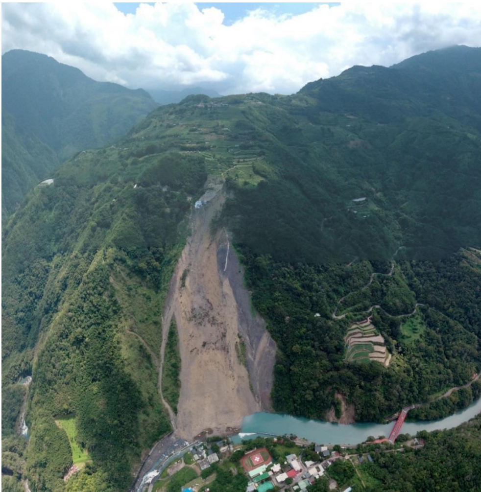
圖 4-2 計畫區域崩塌地空拍照片(水保署於 2021.09.16 拍攝)
