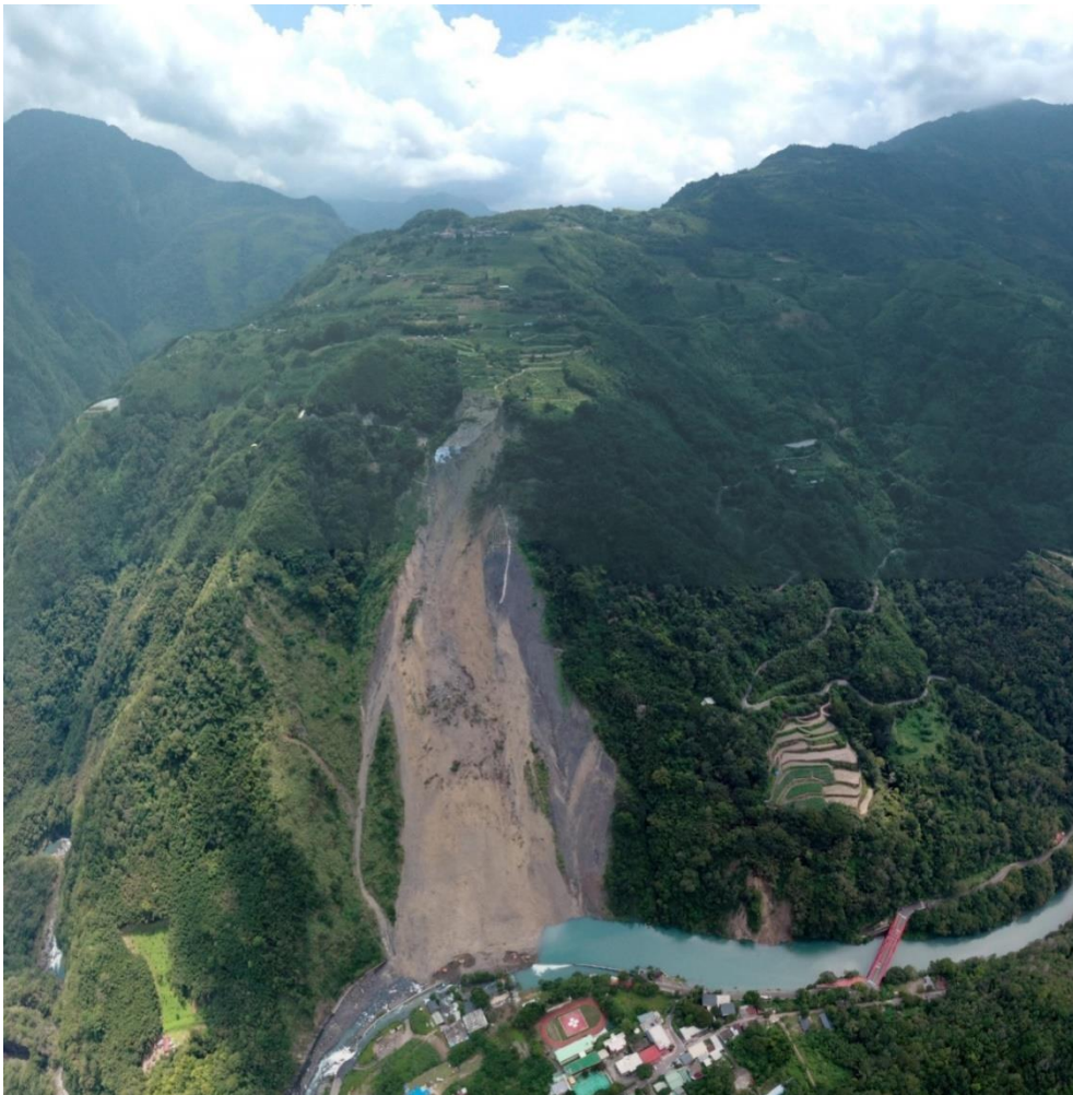
圖 7 計畫區域崩塌地空拍照片(水保署台北分署於 2021.09.16 拍攝)
