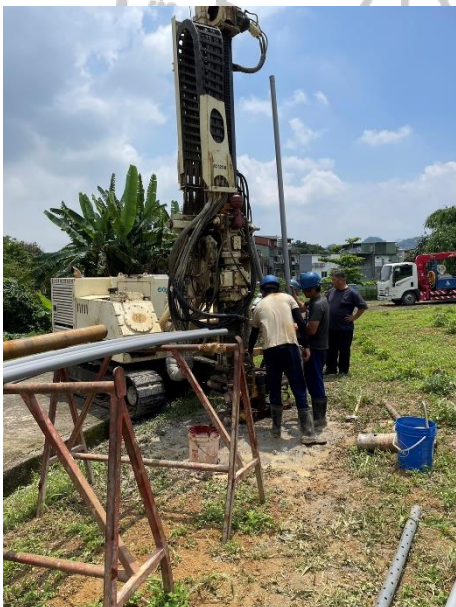
圖 三-20 套管安裝過程
