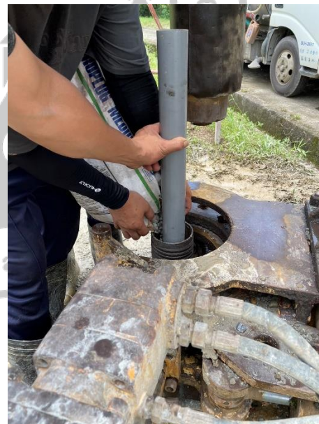
圖 三-21 濾料回填過程
