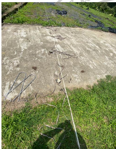
圖 三-9 電阻電極安裝過程
