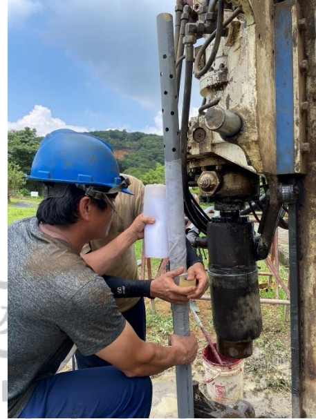
圖 三-19 開篩段保護工程
