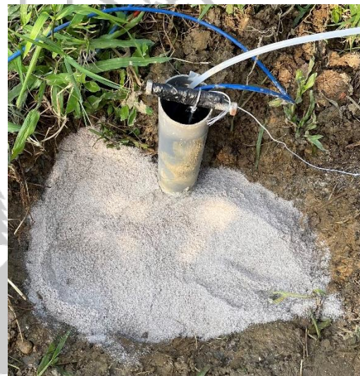
圖 三-53 石英砂回填圖
