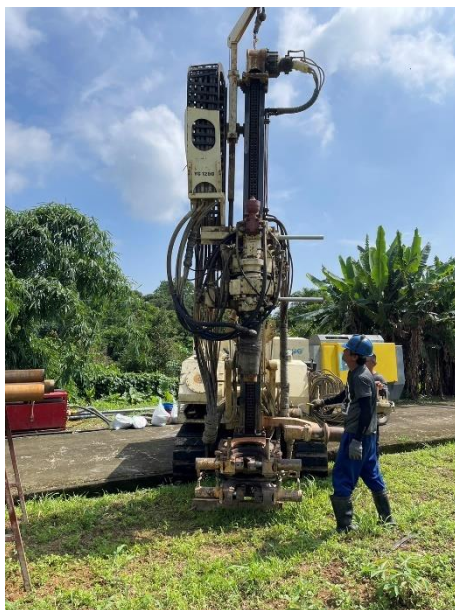
圖 三-13 鑽井機具進場
