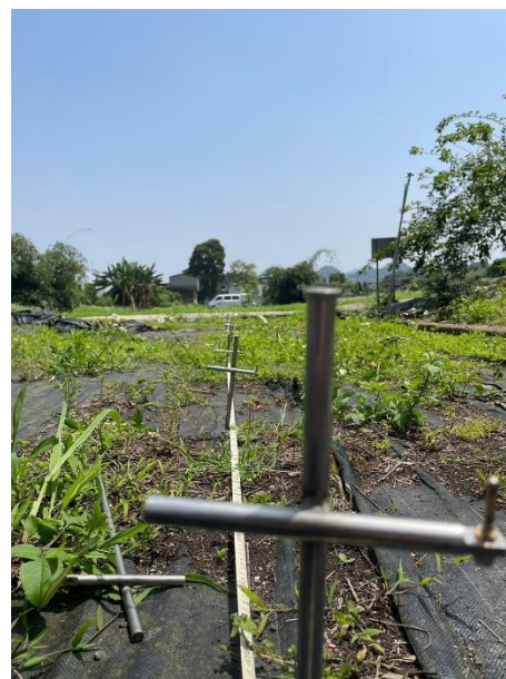
圖 三-8 地電阻佈線過程(2)
