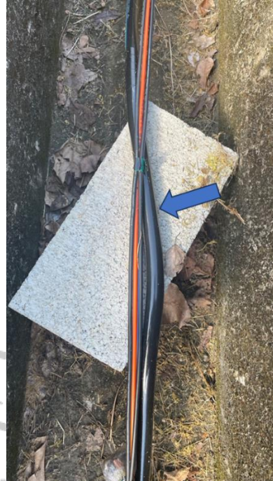
圖 三-41 黑色水管包住氣管
