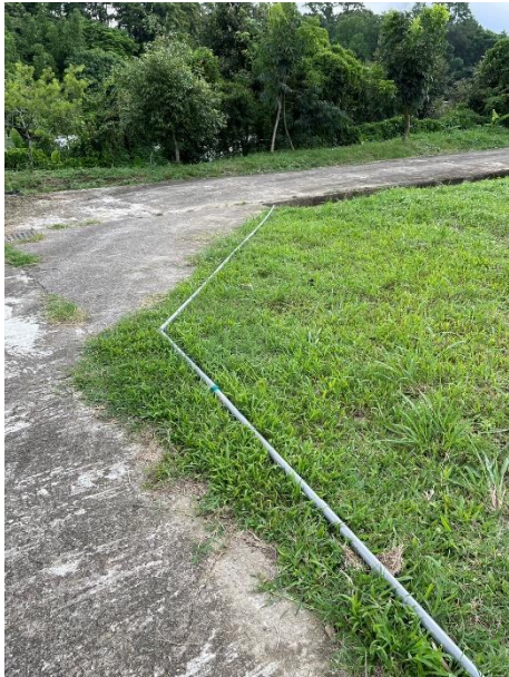
圖 三-28 線路放置於 PVC 管內
