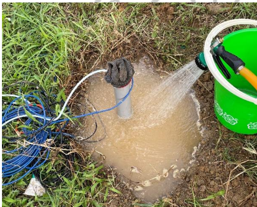
圖 三-52 開挖坑洞灑水及積水
