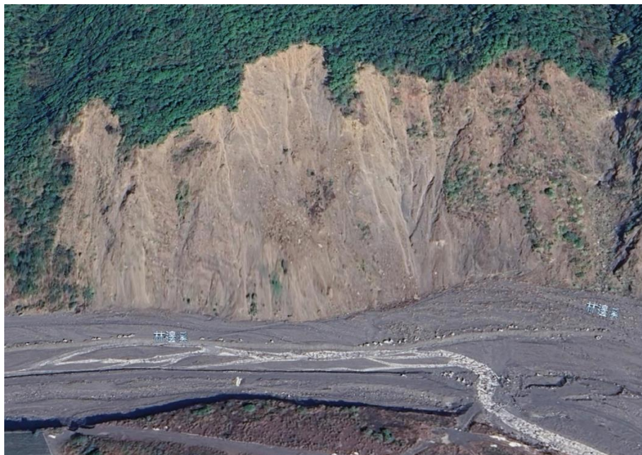
圖 4-14 崩塌潛勢區航照圖
