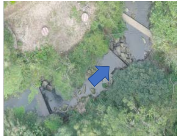
(b)無名橋下游河道現況
