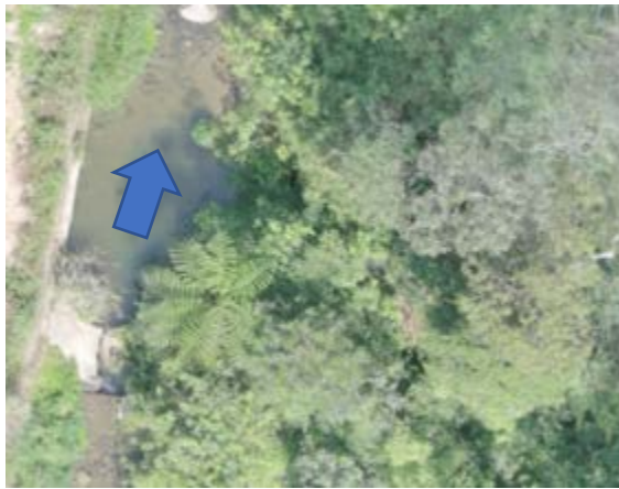
(a)無名橋上游河道現況
