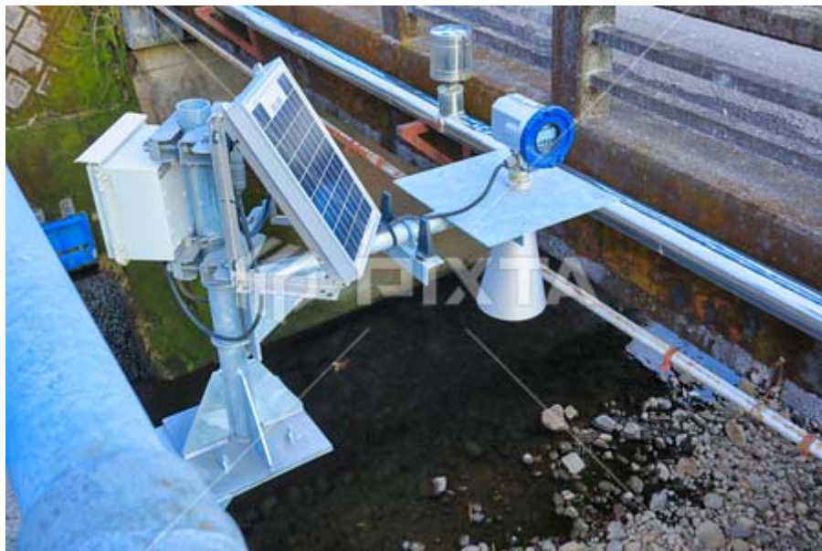
圖 2.2 橋梁上設置水位站
