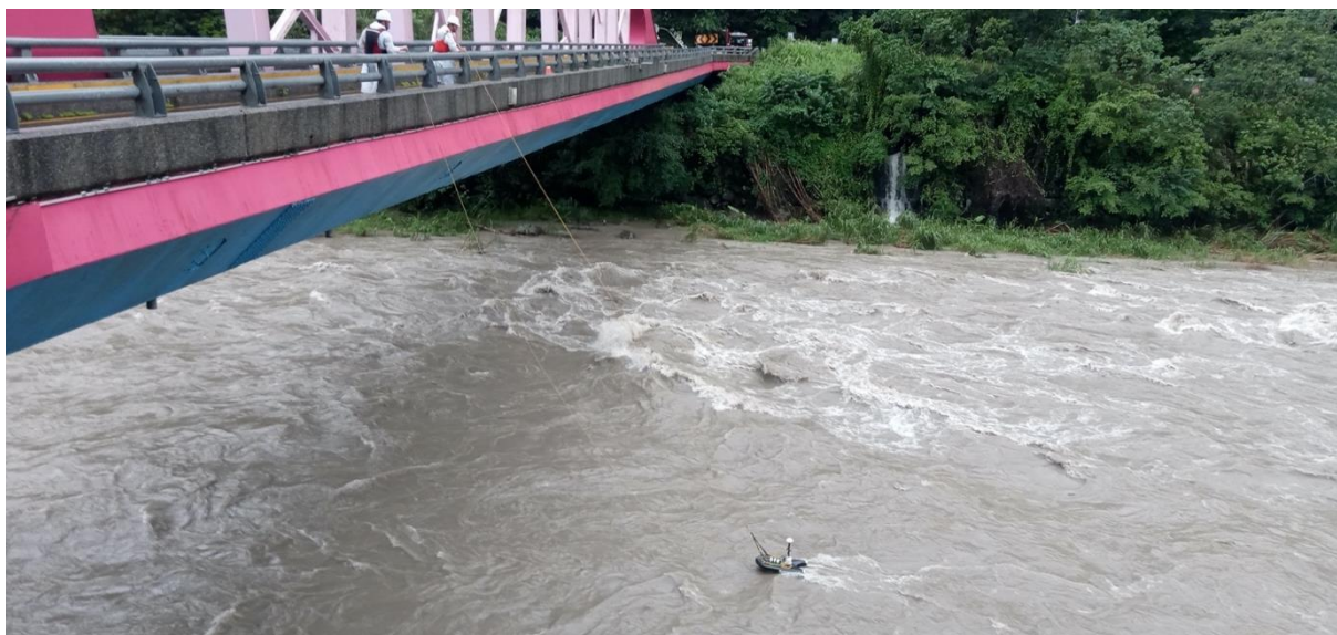
圖 4-15 聲波都卜勒流速剖面儀現場操作情況；以頭前溪支流內灣為例 (2021 盧碧颱風)
