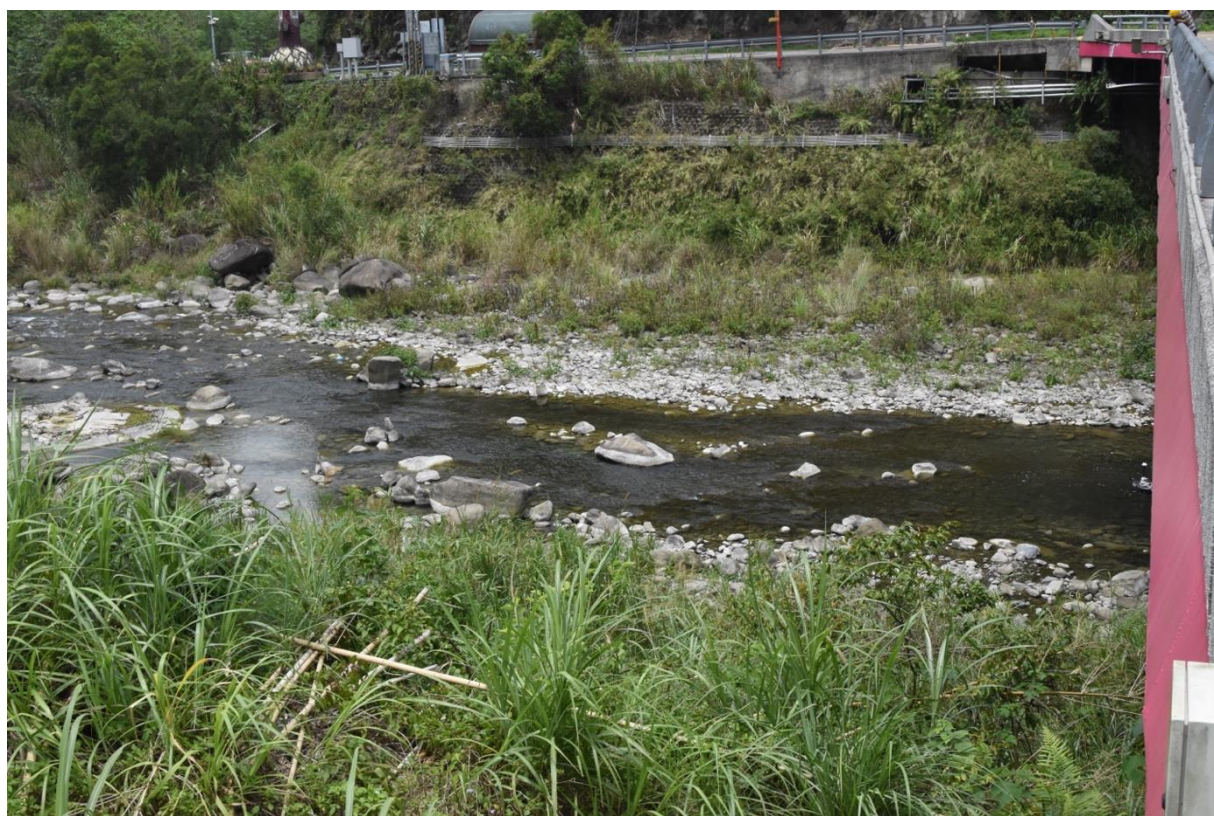
圖 4-5 內灣水位流量站 (義興橋，下游側)
