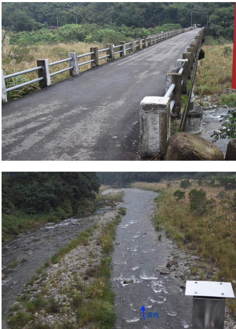
圖 5-6 上坪站現場狀況；橋面與底床
