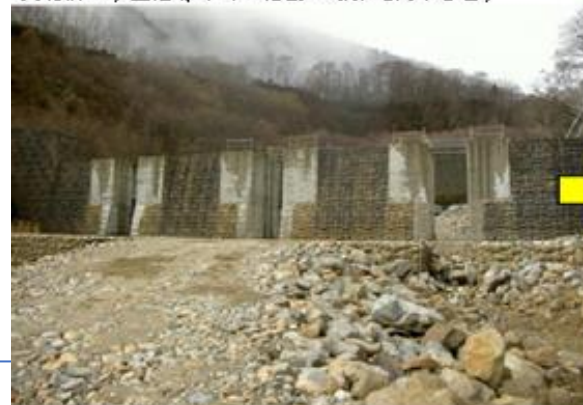
大規模土砂生產前（開啓插板以確保足夠庫容量）
