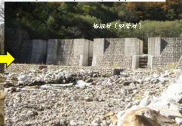
大規模土砂生產後（關閉插板攔阻土砂）
