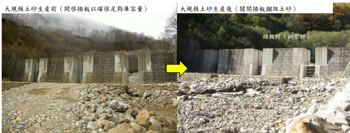
參考圖 4.5.1 砂防對策設施插板壩示意圖 （部分修改自ALPS SABO News 6) ）
