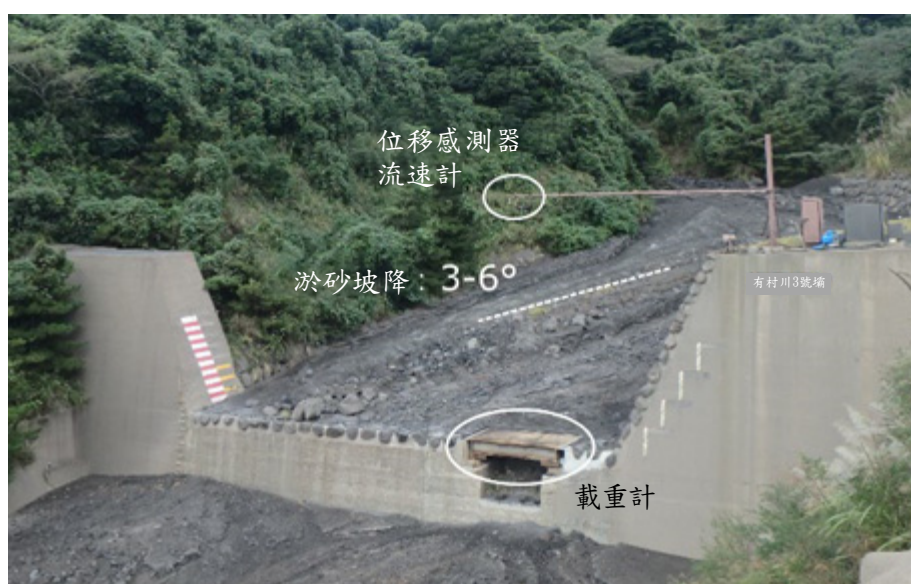
圖 16 2019年10月18日所拍攝堤壩觀測儀器配置狀況
