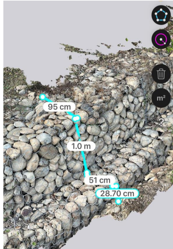
石籠擋土牆/地錨擋土牆
