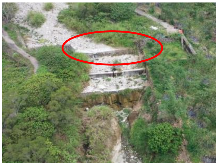
原廊仔溪5K+120舊式傳統型防砂壩
