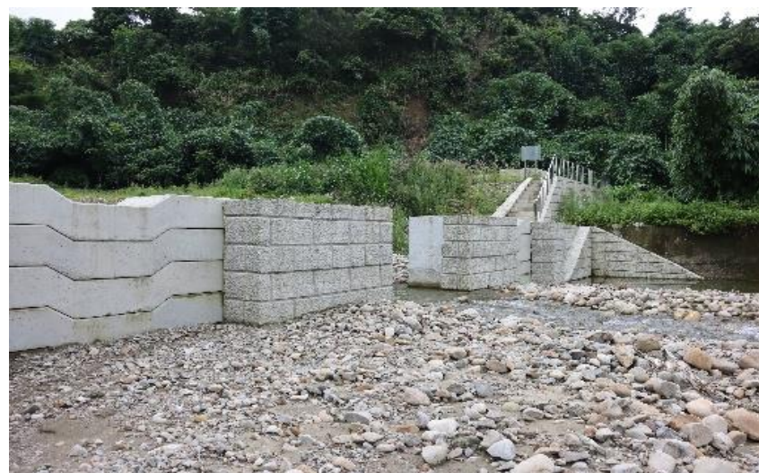
廊仔溪5K+120調整型防砂壩
