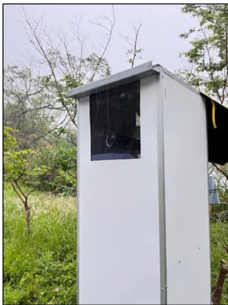
監測小屋外部
