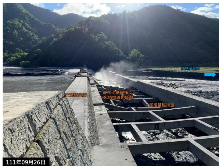
圖3-13 打狗溪三號壩 0925 豪雨事件後損壞情形
