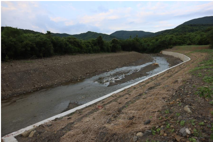
圖3-61 保力村竹社段野溪護岸整治工程
