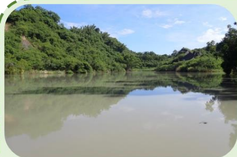
牛埔2號滯洪保水設施改善二期工程
