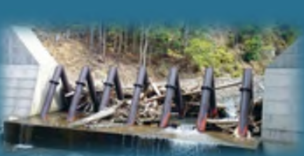
鋼構漂流木捕捉工
