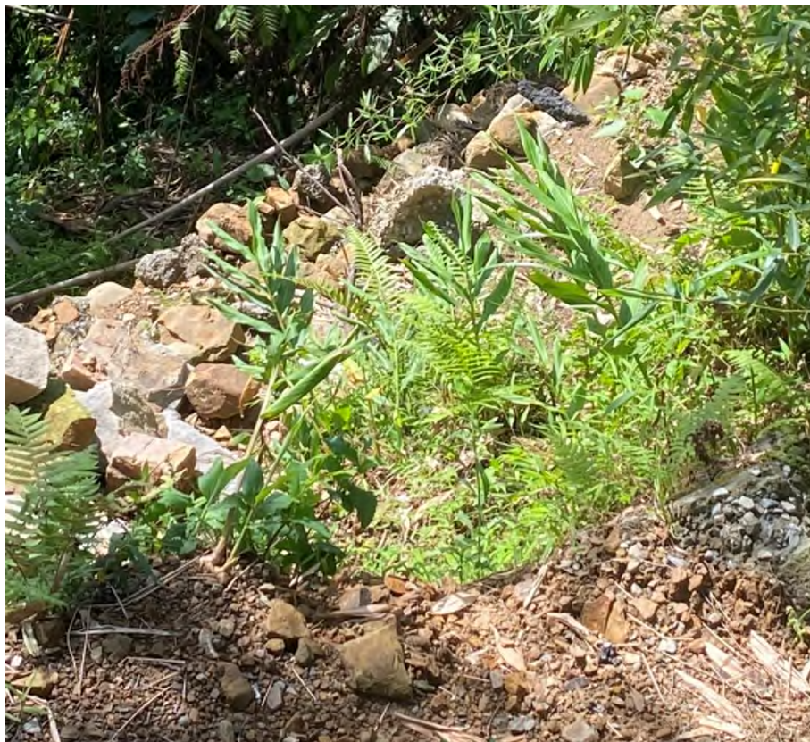
圖(2-13) 大崙山聯外道路崩塌案
