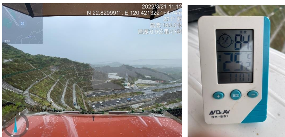
圖 3-35 中寮隧道北側出口 2022/03/21 現地照片
