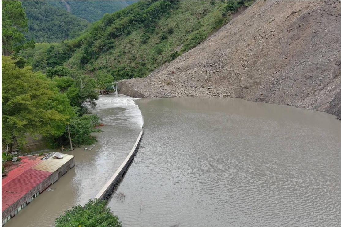
圖 2-7 2021 年 9 月 13 日白石大崩塌現場照
