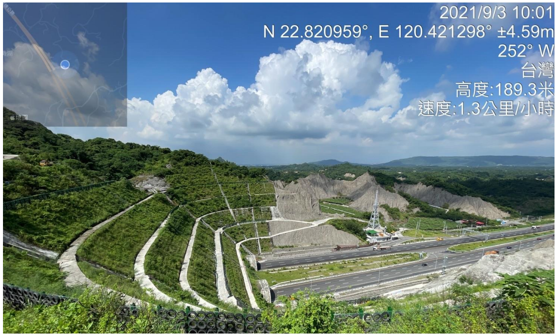
圖 2-19 中寮隧道北洞口 GB-SAR 擺放監測視角(中寮隧道)
