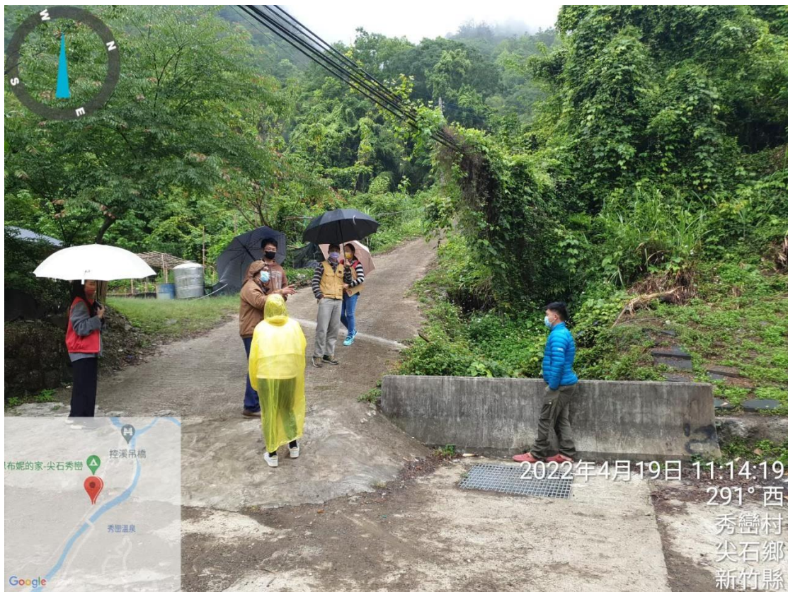
圖 2-11 秀巒崩塌地土石流警戒溪流(2022/4/19)
