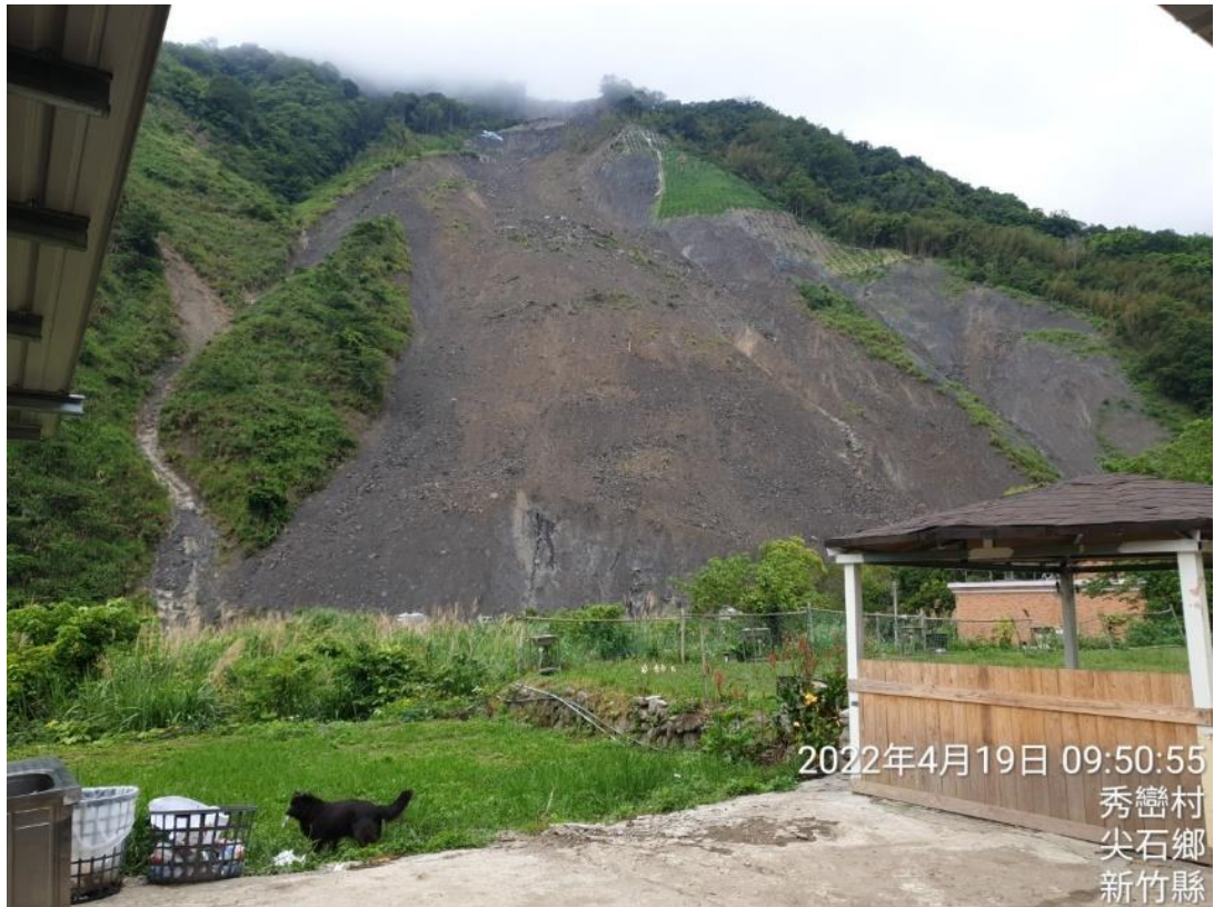
圖 2-14 秀巒崩塌地監測點位視角情況(2022/4/19)
