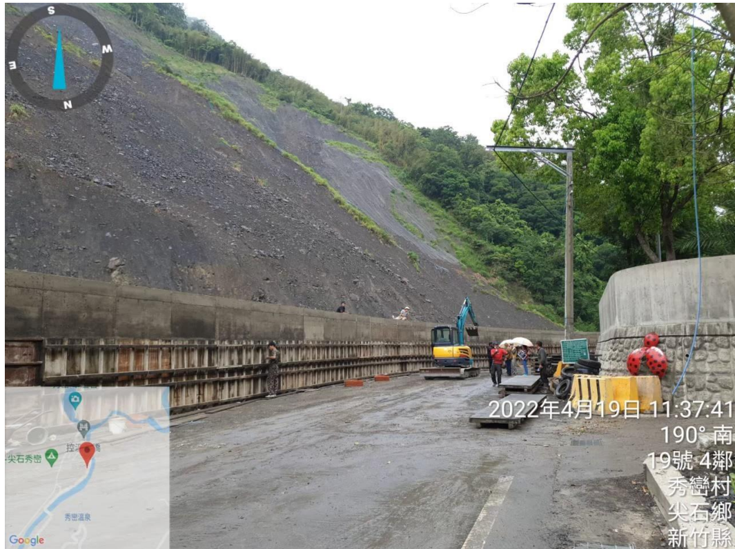
圖 2-8 秀巒崩塌地監測現地勘查檔土牆施工(2022/4/19)
