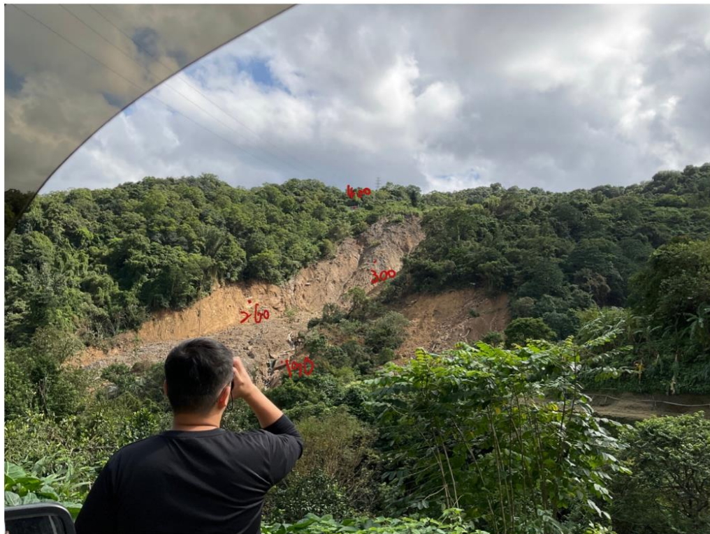
圖 3-46 備選監測位置與邊坡各部位之相對距離標示
