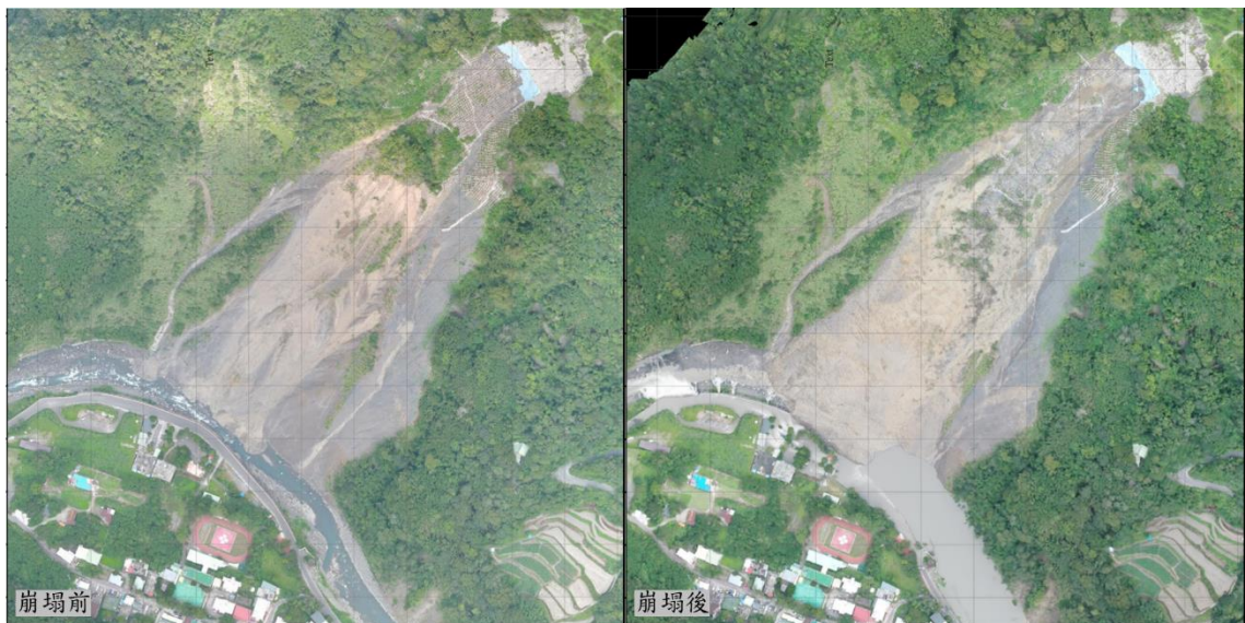
圖 2-6 2021 年 9 月 13 日白石大崩塌空拍照
