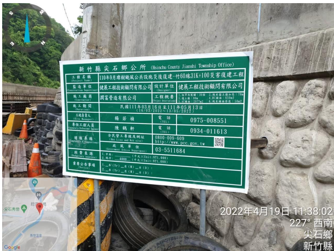
圖 2-9 秀巒崩塌地監測現地勘查檔土牆施工說明(2022/4/19)
