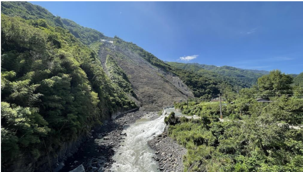
圖 4-1 計畫區域崩塌地照片(團隊於 2021.09.14 拍攝)
