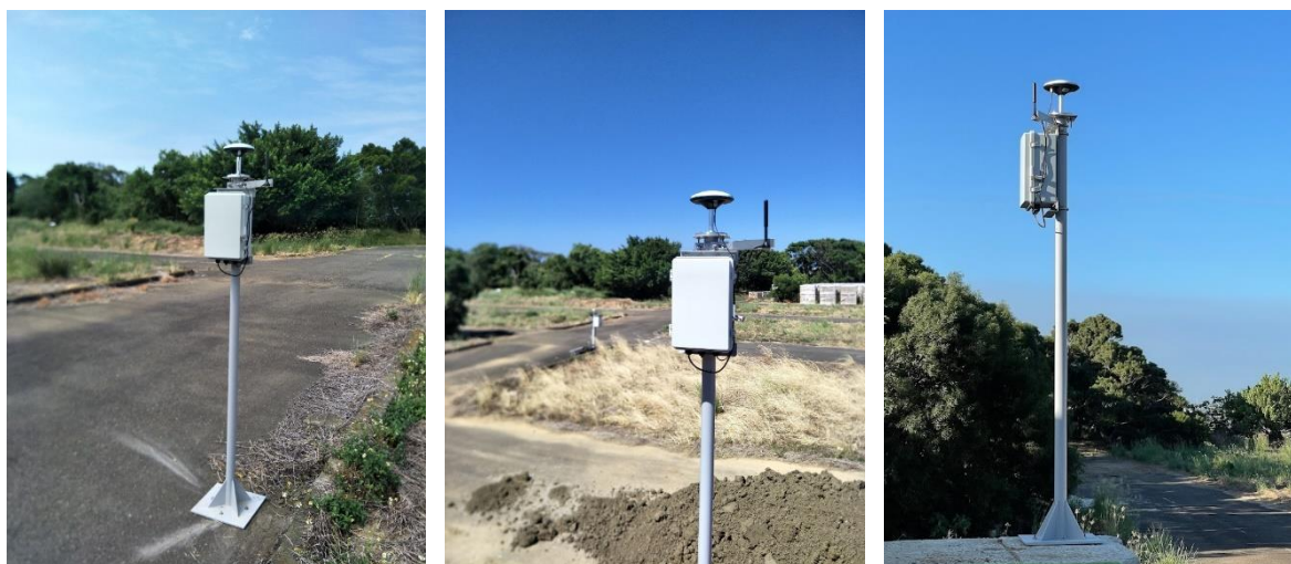
圖 3-12 LoRa-GNSS 與 GNSS-RTK Base 端設備現場照片(於明新科大)
