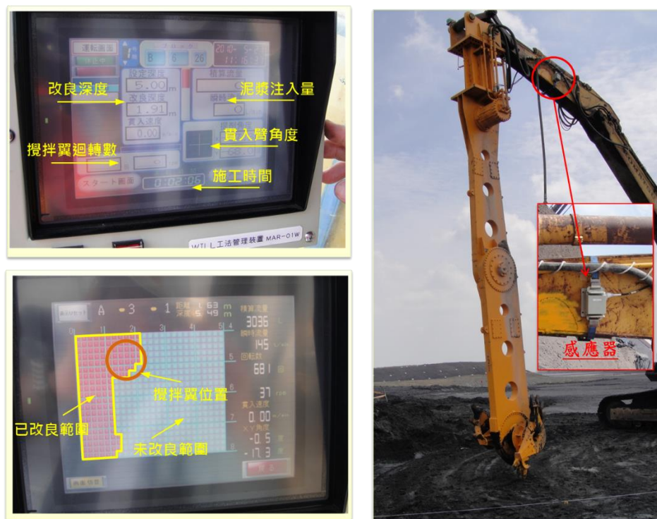
圖附-4 WILL攪拌工法控制系統(台中電廠灰塘區地改試驗)
