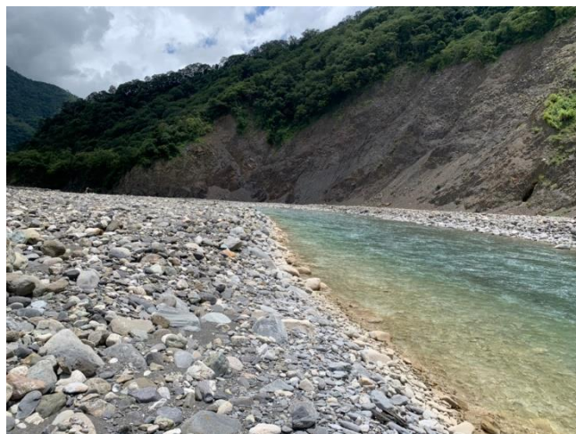
圖5-19 荖濃溪河岸邊坡情形
