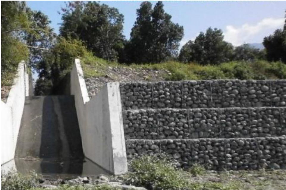
圖5-45 荖濃溪六龜大橋左岸護岸工程(經濟部水利署 2012)
