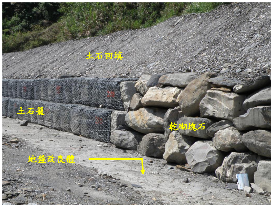
圖2-9 合望溪現地拌合水泥地盤改良施工成果
