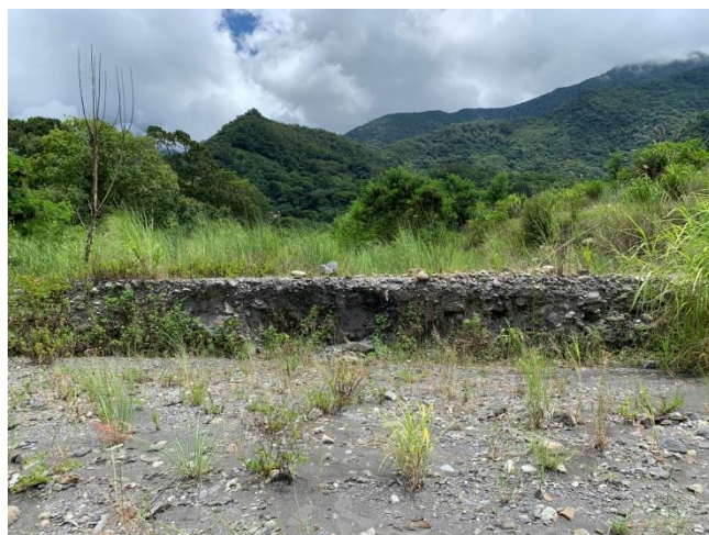
圖5-20 荖濃溪現地土石混凝土堤防
