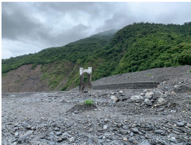
圖5-24 來社溪河岸邊坡情形
