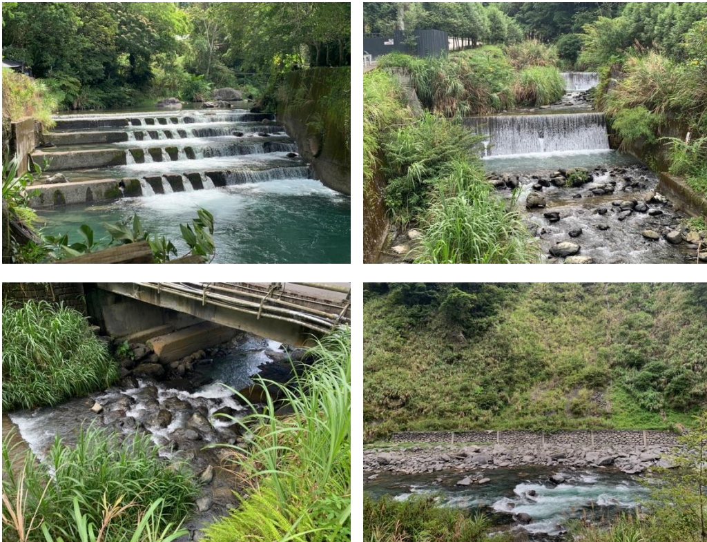
圖5-6 南勢溪河岸護坦與防砂設施
