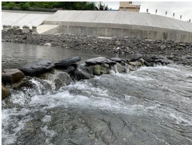
圖5-23來社溪混凝土護岸及砌石固床工
