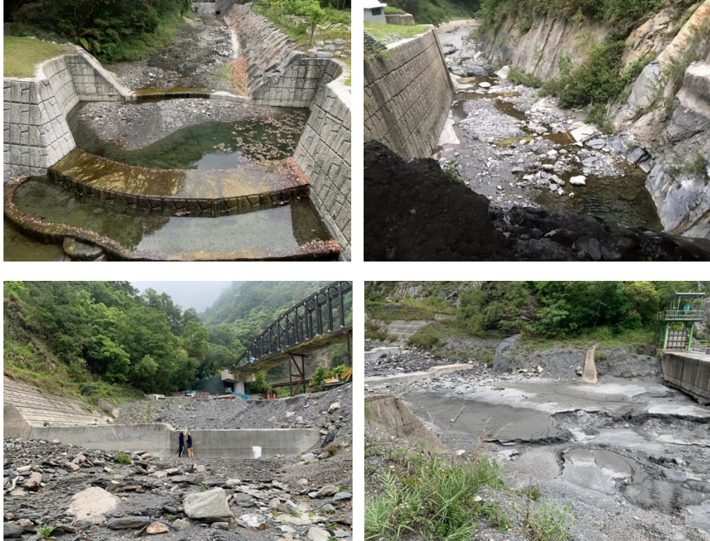
圖5-12 萬大溪河岸護坦與防砂設施
