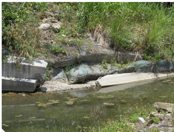
圖5-47 土石籠破壞
