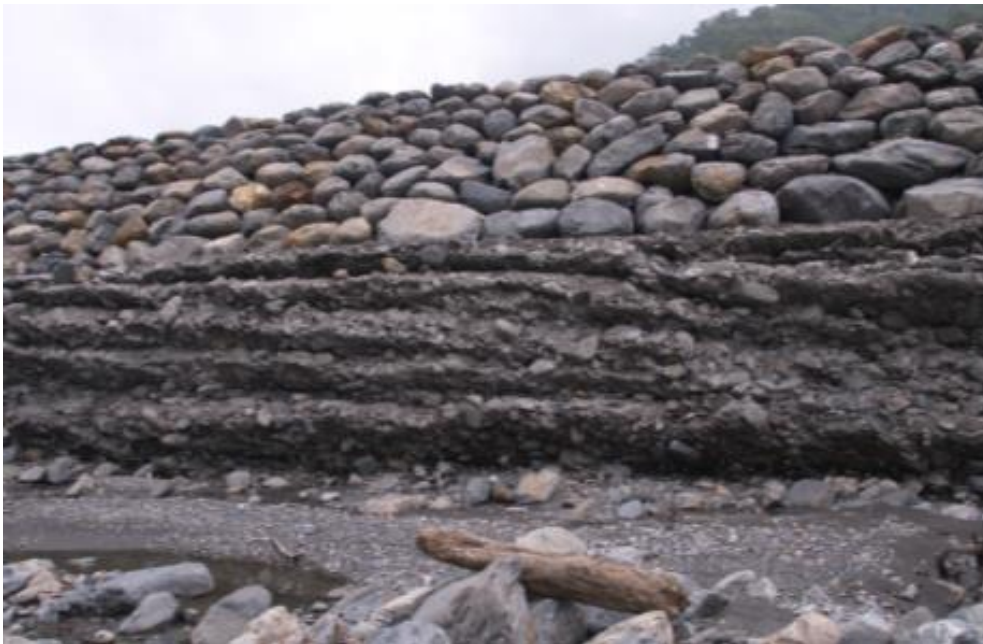
圖2-8 金崙溪現地拌合工法改良體
