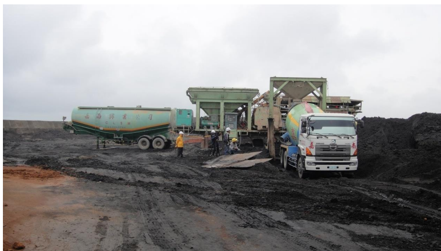
圖附-1 現地拌合法機具配置 (台中電廠灰塘區地改試驗)
